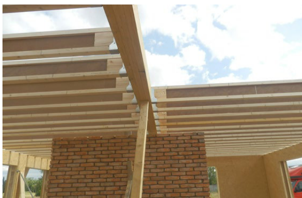
Montaż konstrukcji stropu z belek dwuteowych STEICOjoist (jako belki drugorzędne) oraz ze STEICO LVL R (jako dźwigar główny).
