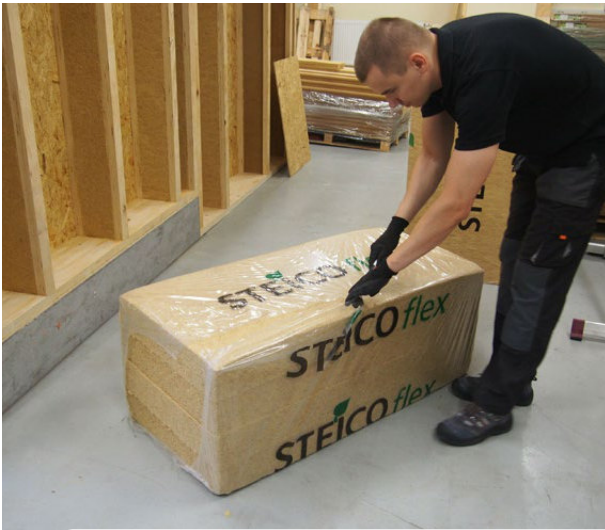
Usunięcie opakowania fabrycznego mat STEICOflex 038.
