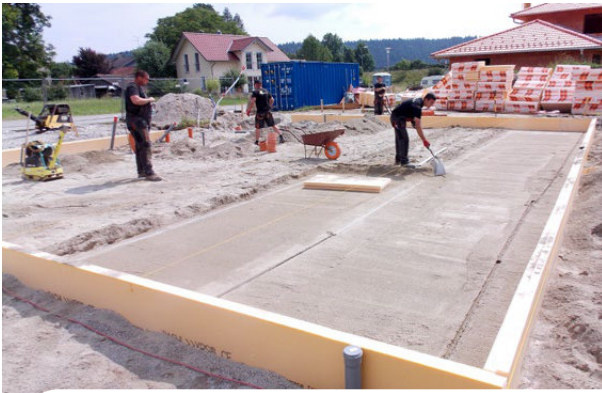
Prace ziemne: przygotowanie płyty fundamentowej. System ogrzewania podłogowego „zatopiony” w płycie fundamentowej.
