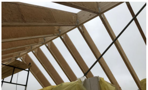
Montaż konstrukcji dachu; mocowanie krokwi STEICOjoist 60x360 mm do kalenicy.
