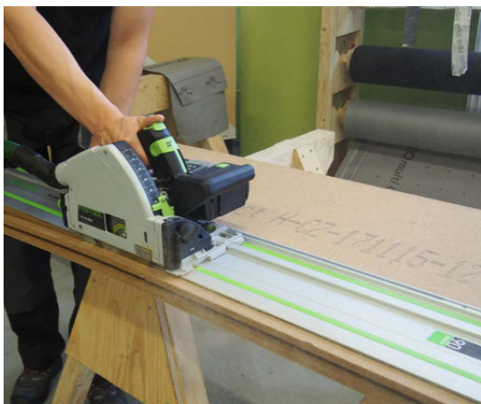
Obróbka płyt nakrokwiowych STEICO przed montażem pierwszego rzędu płyt – usunięcie wpustu.
