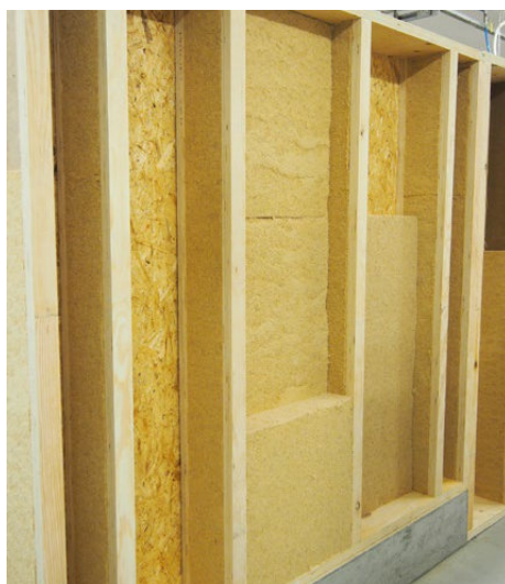
Montaż drugiej warstwy mat STEICOflex 038 – z zachowaniem zakładu w stosunku do spoin między matami w warstwie pierwszej.
