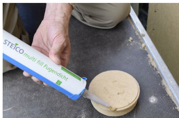
Uszczelnianie otworów po aplikacji granulatu przy pomocy systemowych zatyczek STEICO oraz masy klejąco-uszczelniającej STEICOmulti fill.
