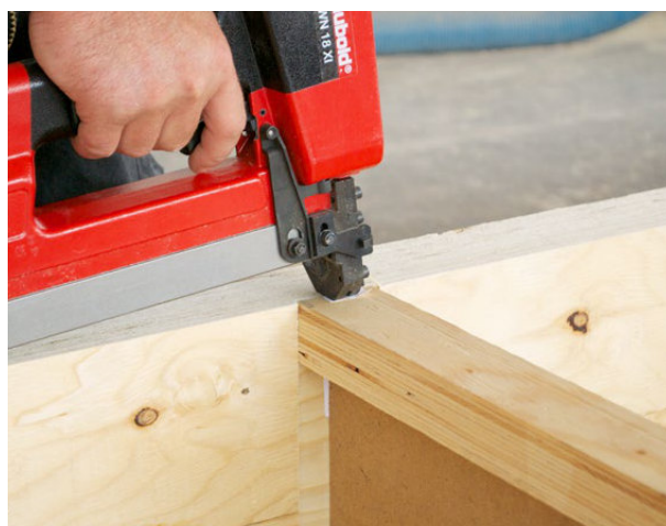
Połączenie belek STEICOWall z podwaliną/oczepem przy pomocy blaszek falistych.
