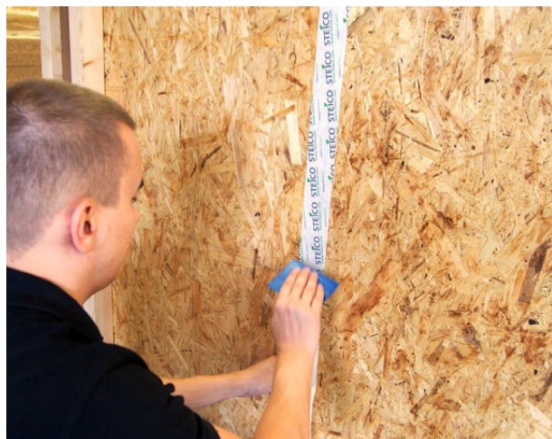
Uszczelnianie spoin między płytami OSB przy użyciu taśmy STEICOmultiprimer P 60 mm.
