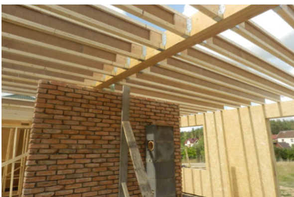
Montaż konstrukcji stropu z belek dwuteowych STEICOjoist (jako belki drugorzędne) oraz ze STEICO LVL R (jako dźwigar główny).
