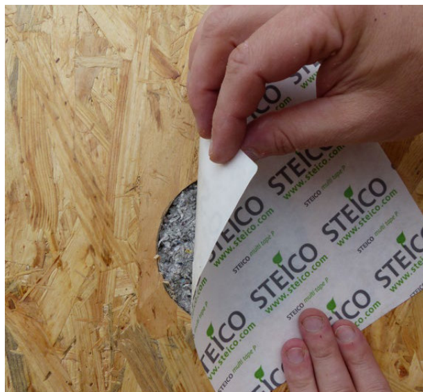
Uszczelnianie otworów po aplikacji granulatu przy pomocy plastrów STEICOmulti tape P.
