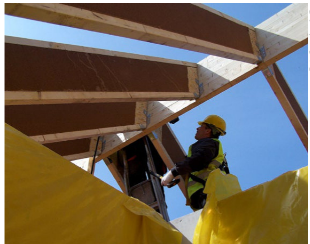
Rys. 146. Mocowanie krokwi STEICOjoist do belki kalenicowej.
