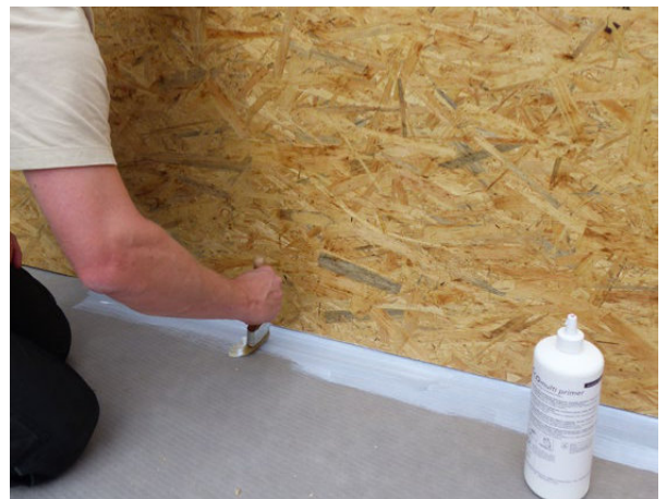
Uszczelnienie połączenia płyta OSB/posadzka – aplikacja gruntu STEICOmulti primer w celu zwiększenia przyczepności podłoża.
