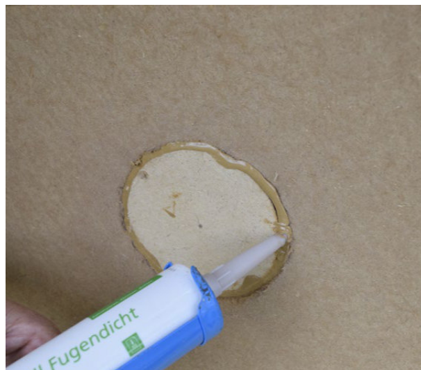
Uszczelnianie otworów po aplikacji granulatu przy pomocy zatyczek STEICO oraz masy klejąco-uszczelniającej STEICOmulti fill.
