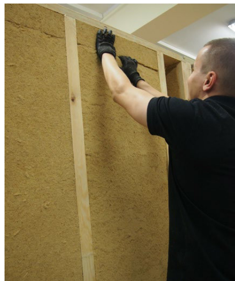
Odmierzenie i przycięcie docelowego odcinka maty STEICOflex 038 z zachowaniem naddatku 10 mm.
