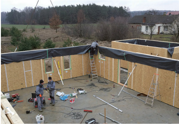
Dalszy montaż ścian zewnętrznych oraz wewnętrznych.
