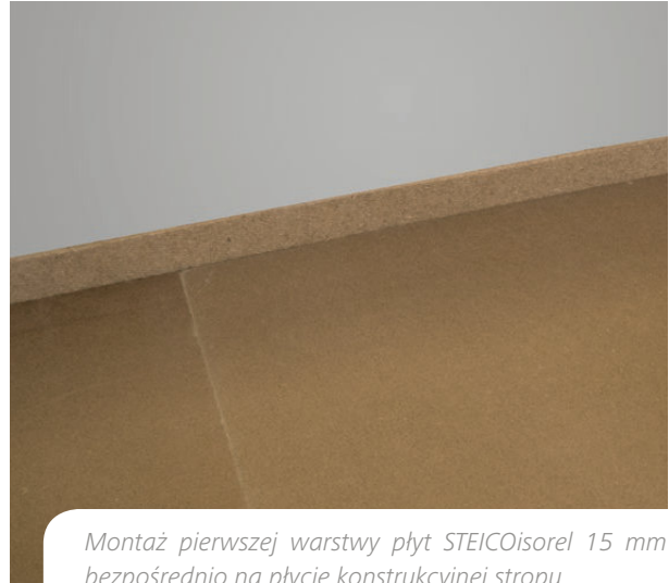
Montaż pierwszej warstwy płyt STEICOisorel 15 mm bezpośrednio na płycie konstrukcyjnej stropu.
