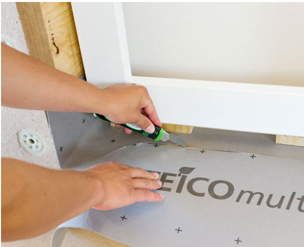
Usunięcie fragmentu membrany STEICO multi UDB po wewnętrznej stronie wbudowanego okna przy pomocy noża introligatorskiego.
