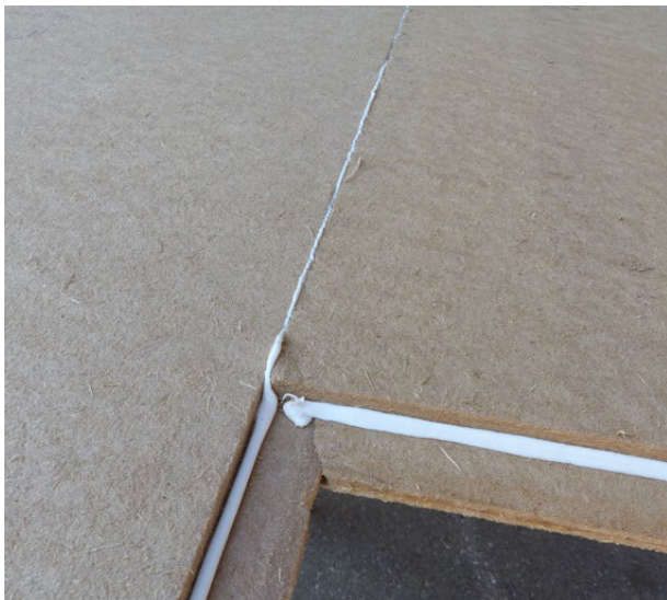
Rozprowadzenie masy STEICOMulti fill na powierzchni piór płyt nakrokwiowych STEICO.
