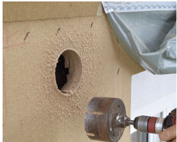
Wykonywanie otworów w płycie termoizolacyjnej STEICO przy użyciu otwornicy do drewna.
