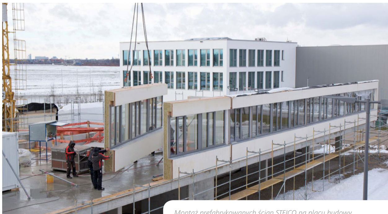
Montaż prefabrykowanych ścian STEICO na placu budowy.
