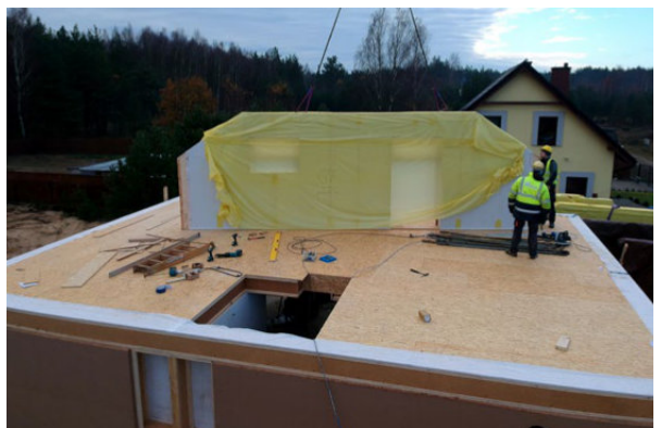
Montaż konstrukcji stropu; rozpoczęcie osadzania prefabrykowanych ścian poddasza.
