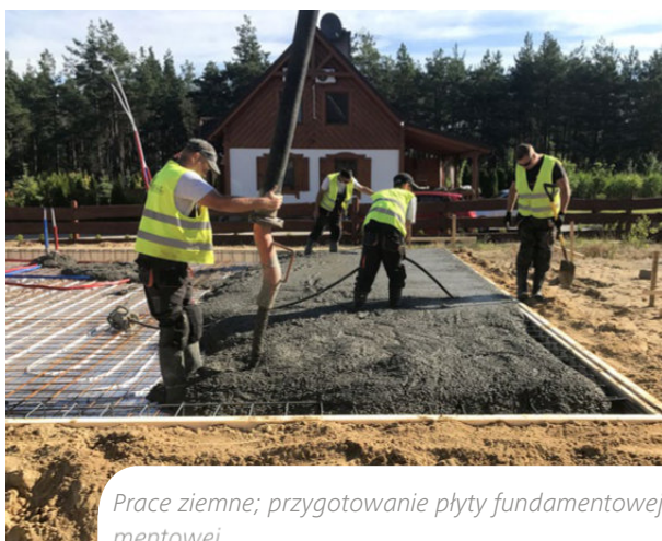
Prace ziemne; przygotowanie płyty fundamentowej. System ogrzewania podłogowego „zatopiony” w płycie fundamentowej.
