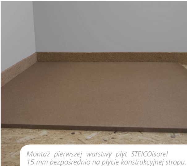
Mocowanie izolacji obwodowej STEICOsoundstrip przy pomocy kleju STEICOmulti connect.
