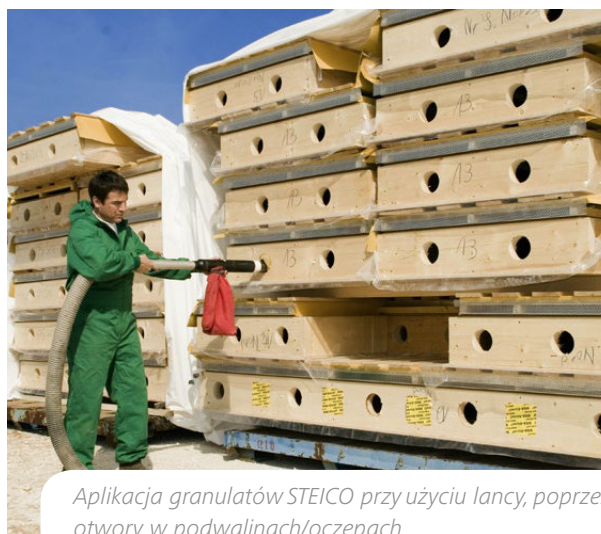
Aplikacja granulatów STEICO poprzez otwory w płytach fasadowych STEICOprotect.
