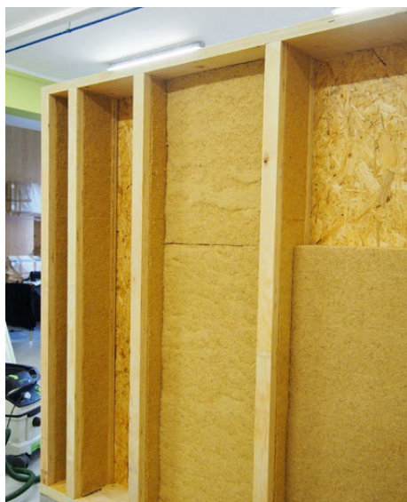
Kontynuacja termoizolacji ściany przy użyciu dociętych fragmentów mat STEICOflex 038.
