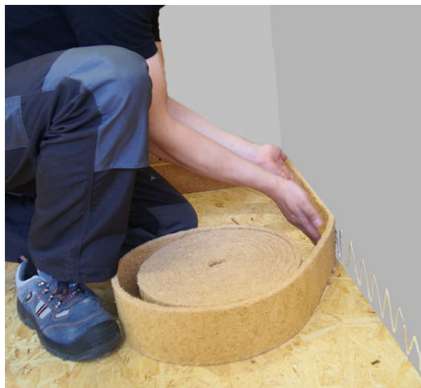
Mocowanie izolacji obwodowej STEICOsoundstrip przy pomocy kleju STEICOmultipoint.
