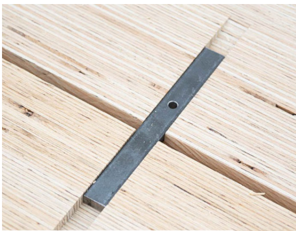
Montaż elementów stropowych ze STEICO GLVL R – aplikacja blaszek stalowych.
