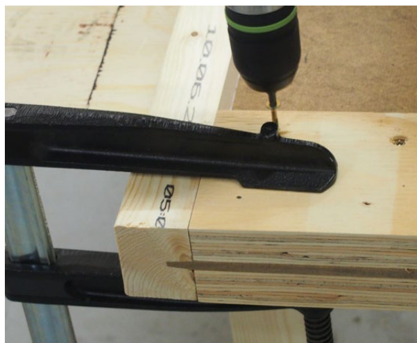
Wzmocnienie środnika belki dwuteowej wykonane z fragmentów płyty STEICO LVL X – mocowanie przy pomocy wkrętów ciesielskich.
