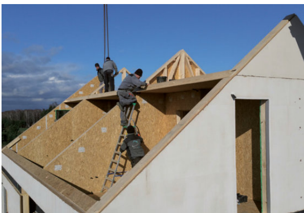
Dalszy montaż konstrukcji dachu.
