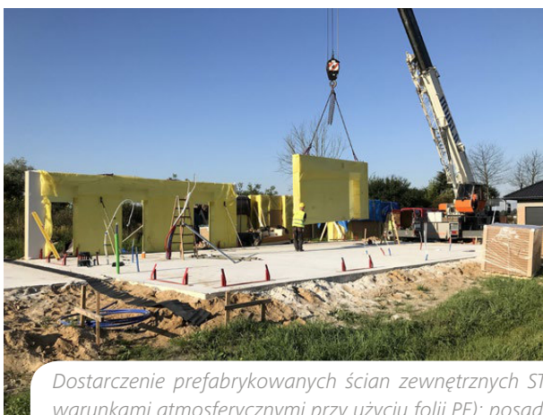
Prefabrykacja ścian STEICO w zakładzie SZREDER A.C.: słupki ścienne z belek dwuteowych STEICOWall 60x240 mm, oczep i podwalina ze STEICO LVL R 45x240 mm; izolacja cieplna STEICOflex 038 240 mm oraz STEICOprotect H 60 mm.
