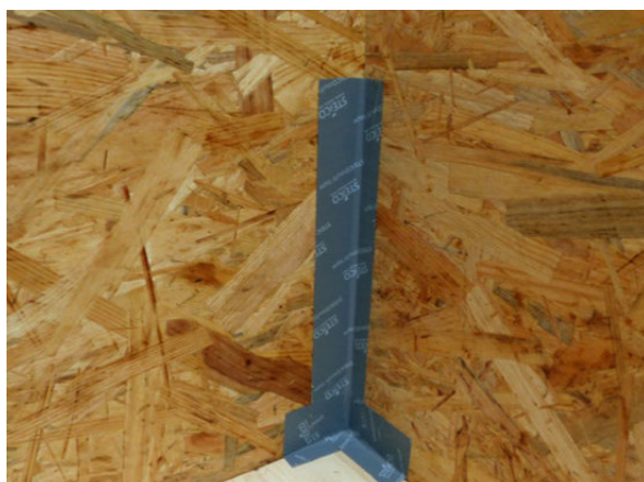
Uszczelnianie spoin między płytami OSB w narożniku przy użyciu taśmy STEICOMulti tape F 60 mm z papierem rozdzielczym.
