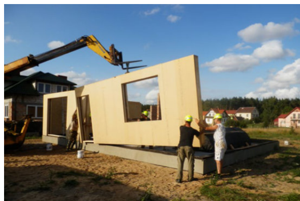
Dostarczenie prefabrykowanych ścian zewnętrznych STEICO na plac budowy; posadzenie i zakotwienie ścian do płyty fundamentowej.
