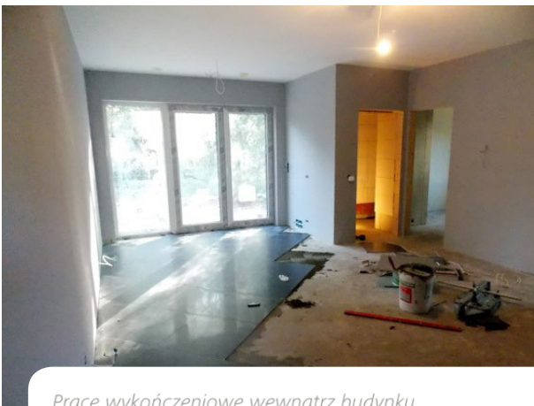
Prace wykończeniowe wewnątrz budynku.
