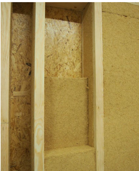
Kontynuacja montażu drugiej warstwy mat STEICOflex 038.
