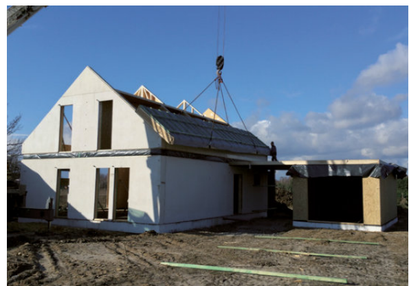
Dostarczenie prefabrykowanych elementów dachowych STEICO na plac budowy; montaż konstrukcji dachu.
