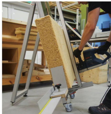
Przycięcie mat STEICOflex 038 do odpowiedniego wymiaru przy użyciu STEICOisoflex cut combi.
