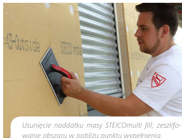
Wypełnienie szczeliny przy pomocy masy STEICOMulti fill.
