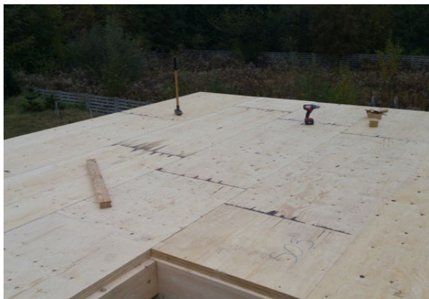
Usztywnienie belek stropowych STEICOjoist przy użyciu płyt STEICO LVL X 27 mm.
