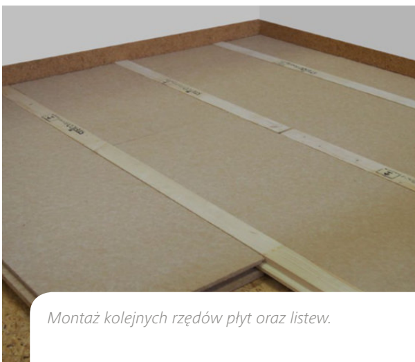
Szczelina dylatacyjna 1-5 mm między listwami montażowymi.
