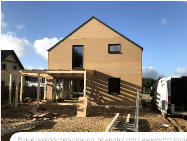
Prace wykończeniowe na zewnątrz oraz wewnątrz budynku.
