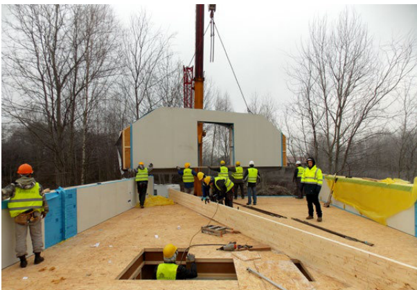
Montaż prefabrykowanych ścian poddasza.
