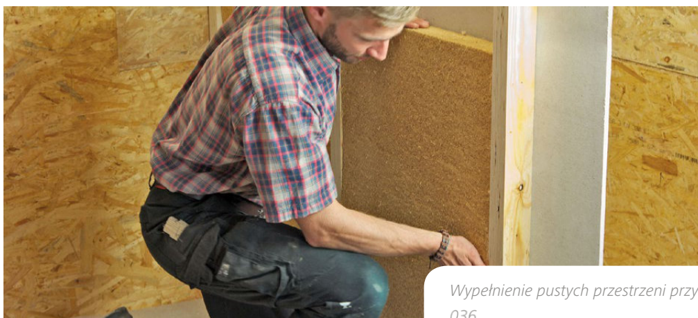
Zachowanie szczeliny dylatacyjnej w przypadku planowanego ugięcia stropu powyżej 10 mm.
