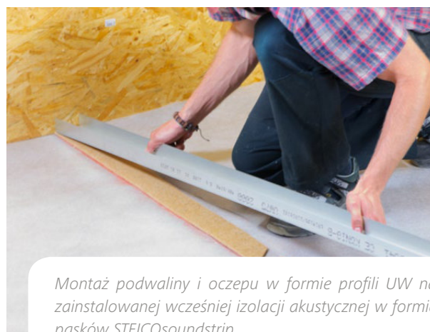
Montaż podwaliny i oczepty STEICO LVL R na zainstalowanej wcześniej izolacji akustycznej w formie pasków STEICO soundstrip .
