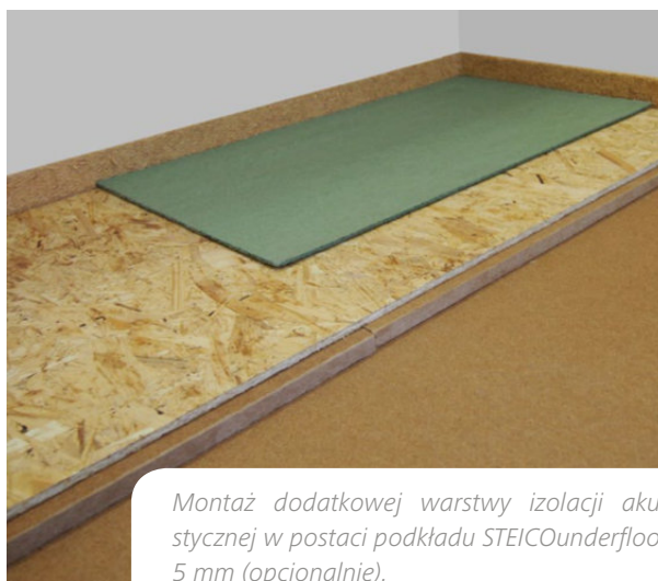
Usztywnienie powierzchni płyt STEICOisorel przed montażem laminowanych paneli podłogowych o grubości < 10 mm.
