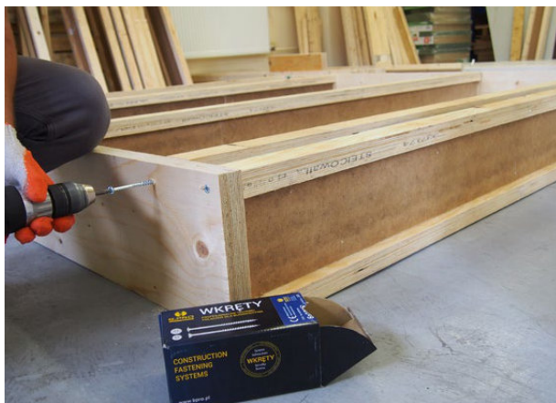
Połączenie belek STEICOWall z podwaliną/oczepem przy pomocy wkrętów ciesielskich.
