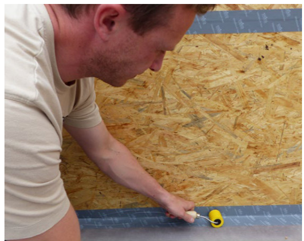
Uszczelnienie połączenia płyta OSB/posadzka – montaż taśmy STEICOmulti tape F 100 mm z papierem rozdzielczym.
