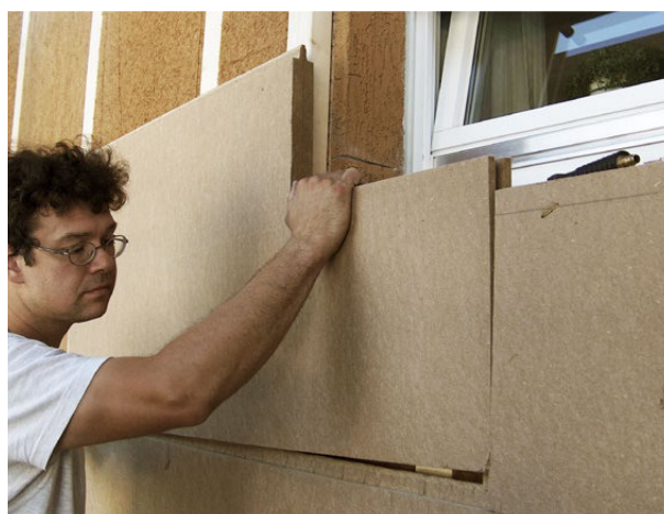
Mocowanie płyt STEICOprotect H 40 mm 1325x600 mm do słupków ściennych STEICOWall przy użyciu zszywek.
