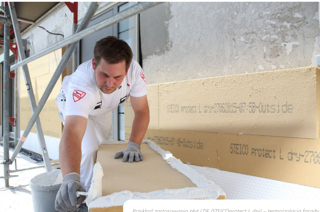
Przykład zastosowania płyt LDF (STEICOprotect L dry) – termoizolacja fasady.
