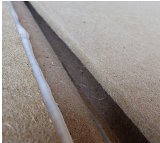
Połączenie płyt nakrokwiowych na profil pióro-wpust.
