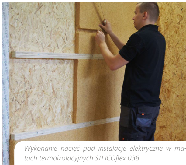
Wypełnienie przestrzeni instalacyjnej matą termoizolacyjną STEICOflex 038 o gr. 50 mm.
