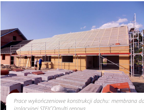
Montaż więźarów kratowych z drewna.
