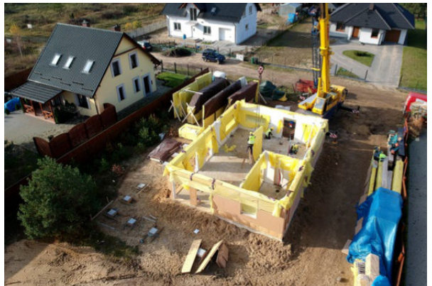
Dostarczenie prefabrykowanych ścian zewnętrznych STEICO na plac budowy (ściany zabezpieczone tymczasowo przed warunkami atmosferycznymi przy użyciu folii PE); posadzenie i zakotwienie ścian do płyty fundamentowej.
