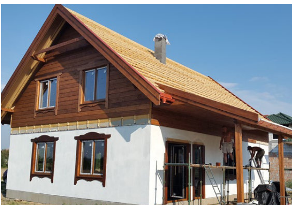
Rozpoczęcie montażu pokrycia dachowego oraz prac wykończeniowych.
