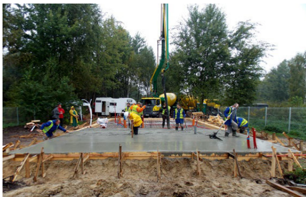
Prace ziemne; przygotowanie płyty fundamentowej.
