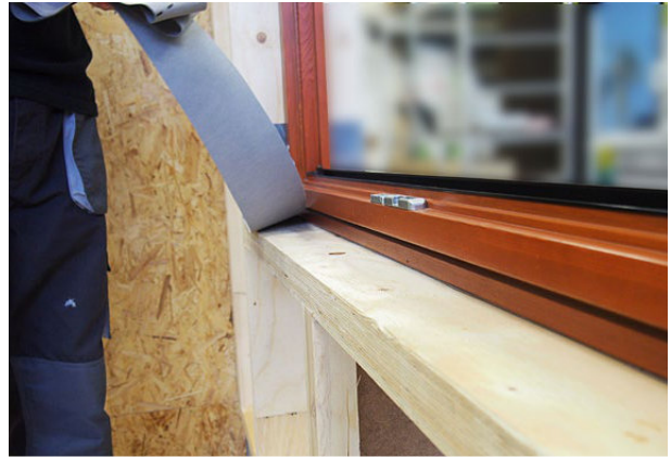
Usunięcie fragmentu membrany STEICO multi UDB po wewnętrznej stronie wbudowanego okna przy pomocy noża introligatorskiego.
