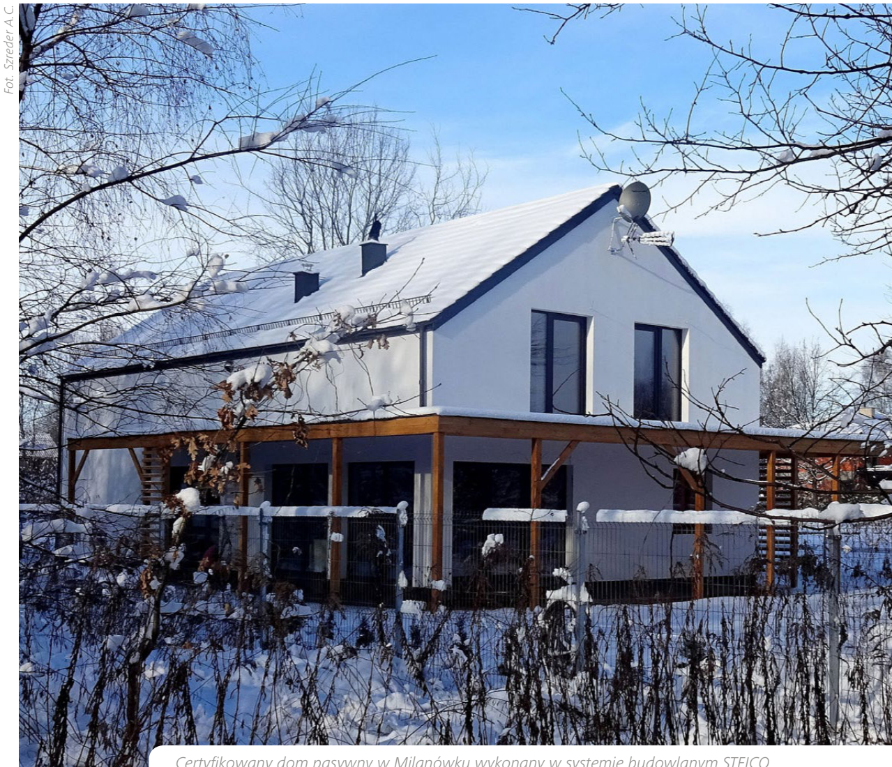
Certyfikowany dom pasywny w Milanówku wykonany w systemie budowlanym STEICO.
