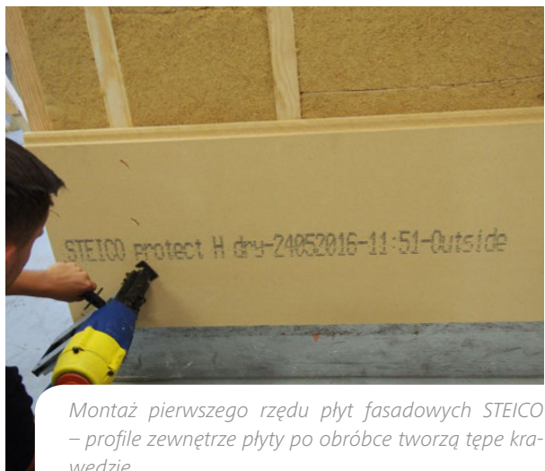
Usunięcie profilu pióro wzdłuż krótszej krawędzi płyt fasadowych STEICO.
