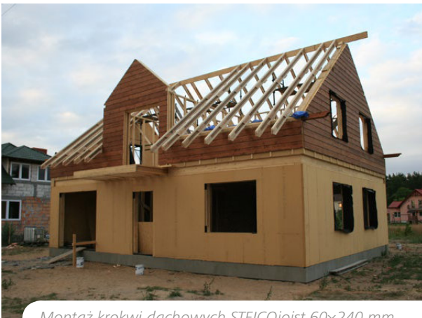
Montaż krokwi dachowych STEICOjoist 60×240 mm
