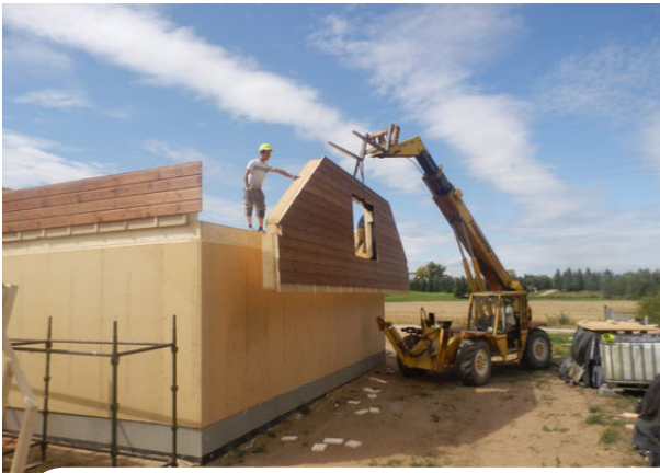
Montaż prefabrykowanych ścian zewnętrznych STEICO na stropie – ściany szczytowe i kalenicowe.
