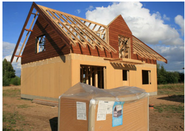
Montaż prefabrykowanych ścian zewnętrznych STEICO na stropie – ściany szczytowe i kalenicowe.
