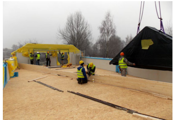
Montaż konstrukcji stropu; rozpoczęcie osadzania prefabrykowanych ścian poddasza.
