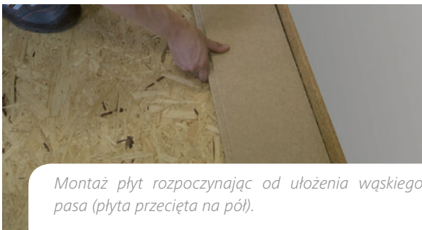
Rys. 144. Prawidłowy montaż systemu STEICOfloor.
