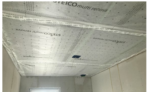
Montaż więźarów kratowych z drewna. Prace wykończeniowe konstrukcji dachu: zainstalowana membrana dachowa STEICOmulti UDB; montaż membrany paroizolacyjnej STEICOmulti renova.
