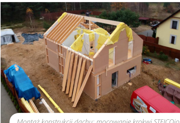
Montaż konstrukcji dachu; mocowanie krokwi STEICOjoist 60x360 mm do kalenicy.
