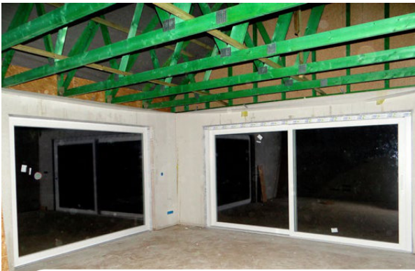
Montaż więźarów kratowych z drewna. Prace wykończeniowe konstrukcji dachu: zainstalowana membrana dachowa STEICOmulti UDB; montaż membrany paroizolacyjnej STEICOmulti renova.
