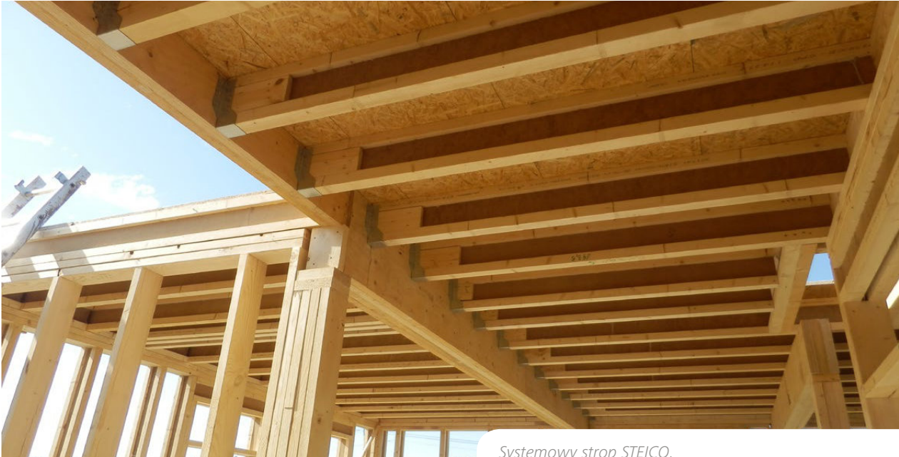
Systemowy strop STEICO.
