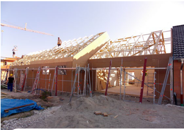
Montaż więźarów kratowych z drewna.
