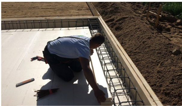
Prace ziemne: przygotowanie płyty fundamentowej. System ogrzewania podłogowego „zatopiony” w płycie fundamentowej.
