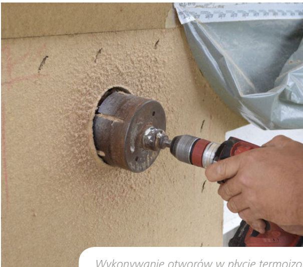
Wykonywanie otworów w płycie termoizolacyjnej STEICO przy użyciu otwornicy do drewna.
