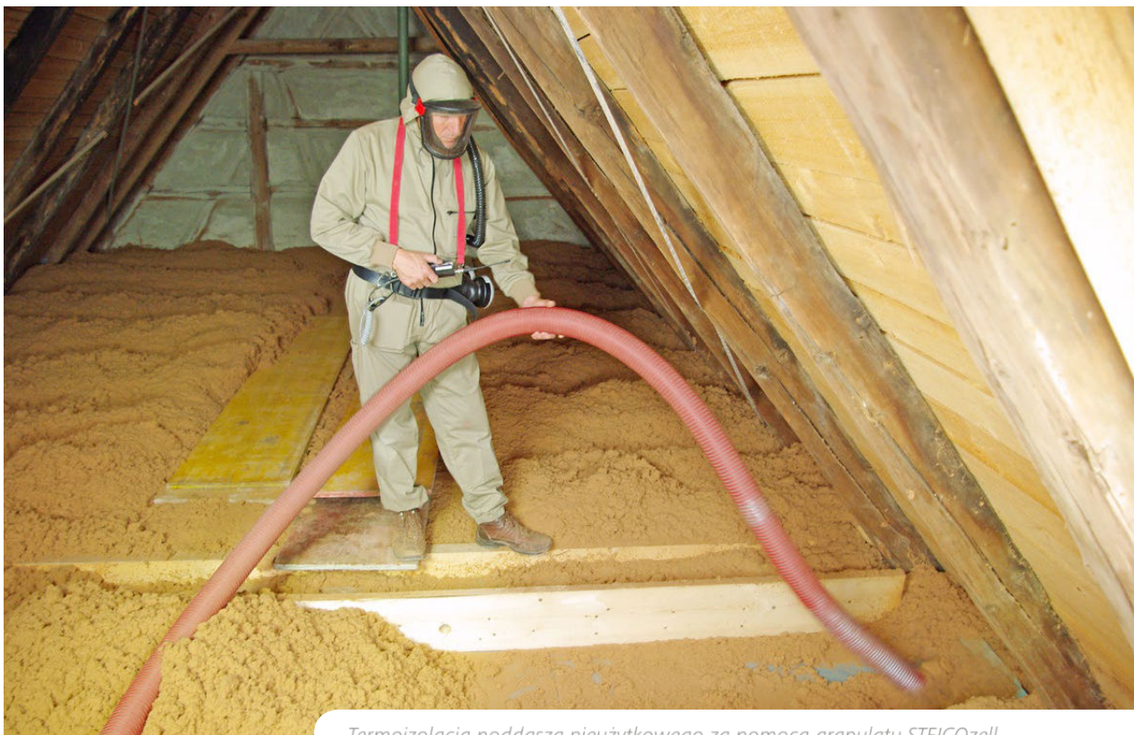
Termoizolacja poddasza nieużytkowego za pomocą granulatu STEICOzell.
