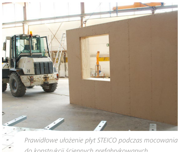
Prawidłowe ułożenie płyt STEICO podczas mocowania do konstrukcji ściennych prefabrykowanych.
