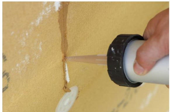
Wypełnienie szczeliny przy pomocy masy STEICOMulti fill.
