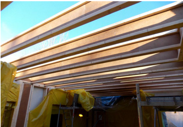
Montaż konstrukcji stropu; rozpoczęcie osadzania prefabrykowanych ścian poddasza.
