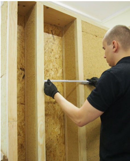
Odmierzenie i przycięcie docelowego odcinka maty STEICOflex 038 z zachowaniem naddatku 10 mm.
