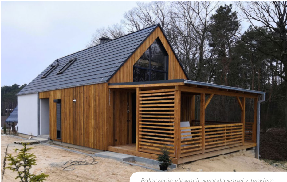
Połączenie elewacji wentylowanej z tynkiem.
