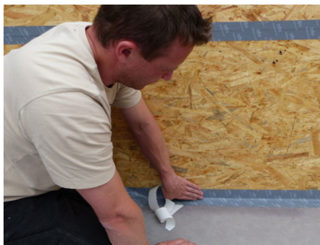
Uszczelnienie połączenia płyta OSB/posadzka – montaż taśmy STEICOmulti tape F 100 mm z papierem rozdzielczym.
