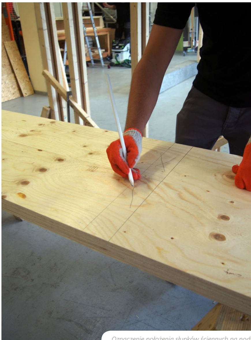
Oznaczenie położenia słupków ściennych na podwalinie ze STEICO LVL R/X.
