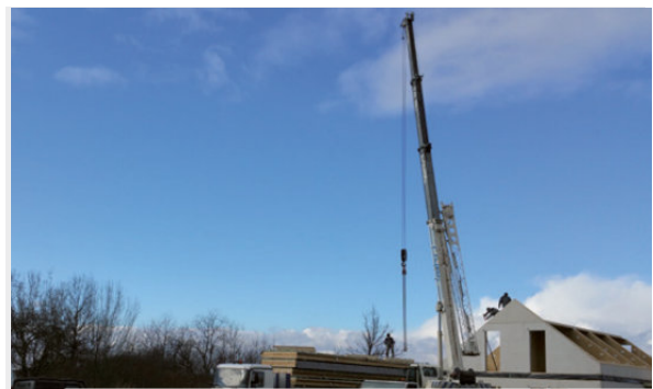
Dostarczenie prefabrykowanych elementów dachowych STEICO na plac budowy; montaż konstrukcji dachu.
