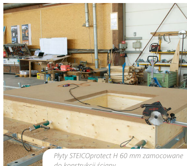
Wycięcie otworu okiennego.
