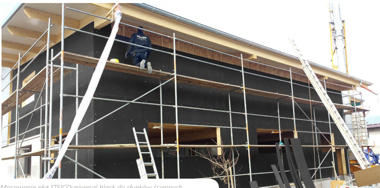
Mocowanie płyt STEICOuniversal black do słupków ściennych.
