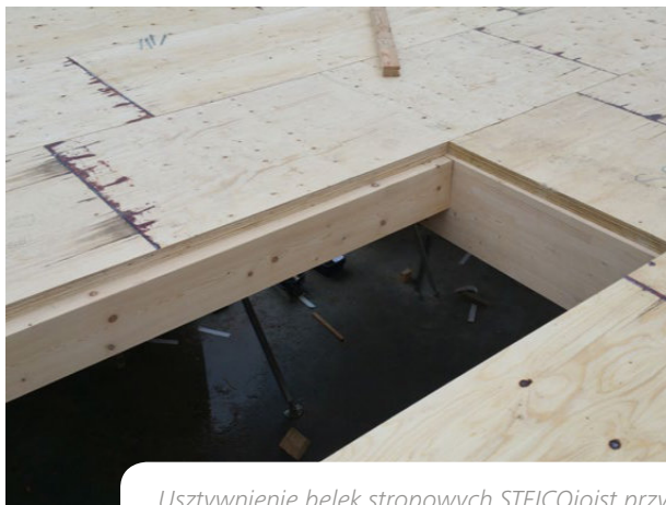
Usztywnienie belek stropowych STEICOjoist przy użyciu płyt STEICO LVL X 27 mm.
