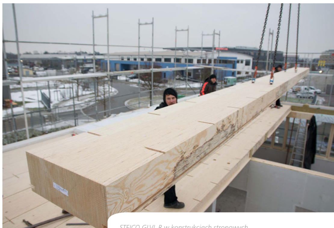
STEICO GLVL R w konstrukcjach stropowych.
