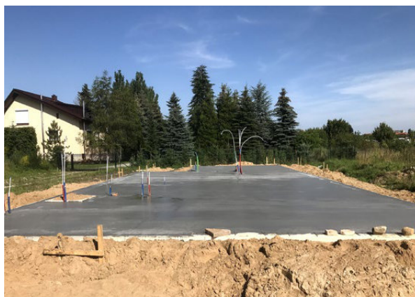
Prace ziemne: przygotowanie płyty fundamentowej. System ogrzewania podłogowego „zatopiony” w płycie fundamentowej.
