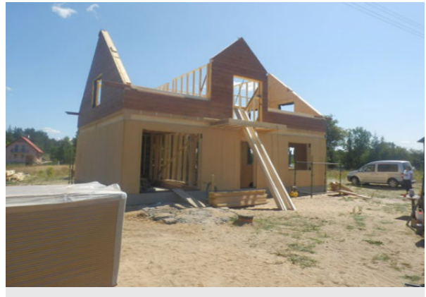
Montaż prefabrykowanych ścian zewnętrznych STEICO na stropie – ściany szczytowe i kalenicowe.
