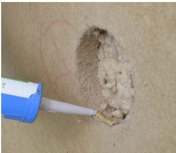
Uszczelnianie otworów po aplikacji granulatu przy pomocy zatyczek STEICO oraz masy klejąco-uszczelniającej STEICOmulti fill.
