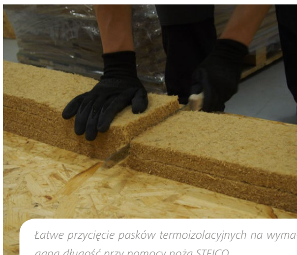
Systemowe paski do termoizolacji belek dwuteowych.
