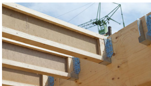
Mocowanie drugorzędnych belek STEICOjoist do wieszaków zamontowanych doczołowo na belce głównej ze STEICO LVL R/ GLVL R.
