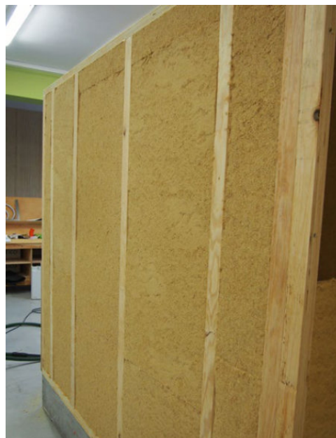
Prawidłowo wykonana termoizolacja przestrzeni między słupkami STEICOWall.
