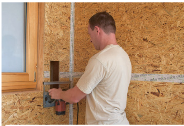
Wycięcie otworu w powłoce uszczelniającej (płyta OSB/membrana paroizolacyjna) na kołnierz STEICO multi box . Rozmiar otworu wynosi 14 × 28 cm (szer. × wys.). Kołnierz może zostać zamontowany w pozycji poziomej lub pionowej.
