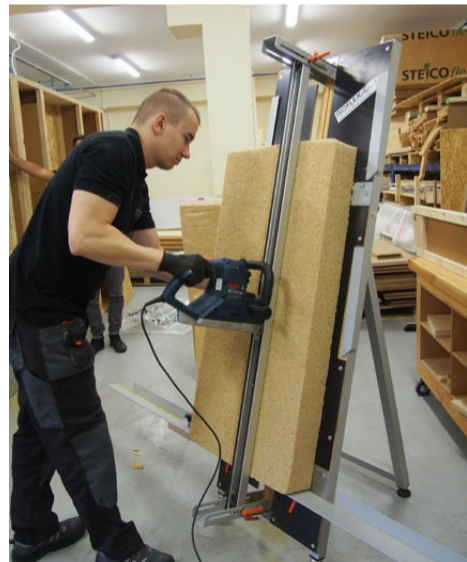
Odmierzenie i przycięcie docelowego odcinka maty STEICOflex 038 z zachowaniem naddatku 10 mm.
