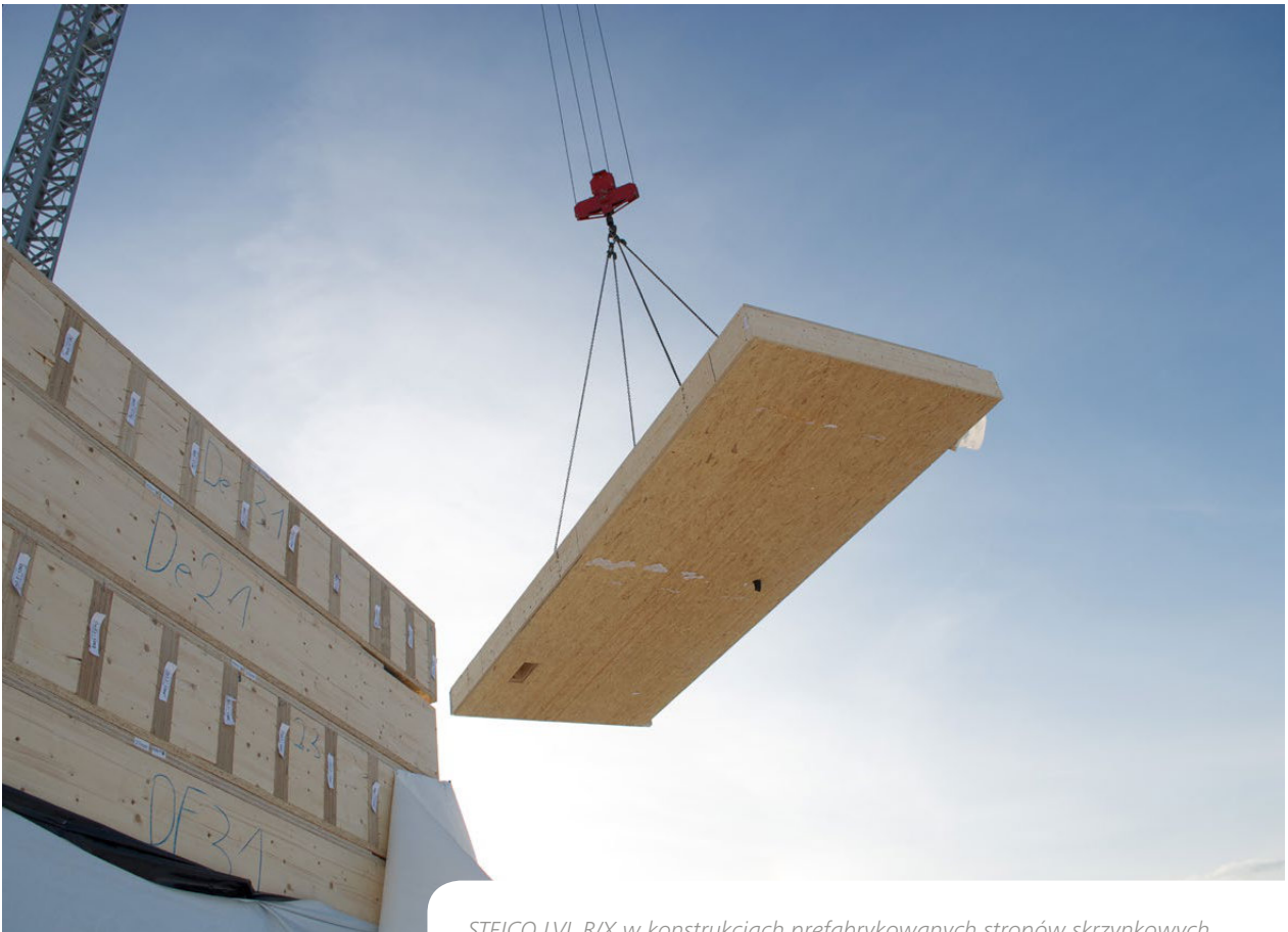
STEICO LVL R/X w konstrukcjach prefabrykowanych stropów skrzynkowych.
