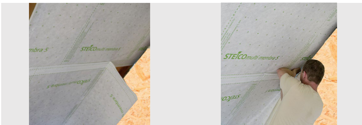
Połączenie pasów membrany STEICOmulti membra 5 z zachowaniem zakładu, zgodnie z oznakowaniem fabrycznym w postaci linii pomocniczych/montaż membrany prostopadle do krokwi.
