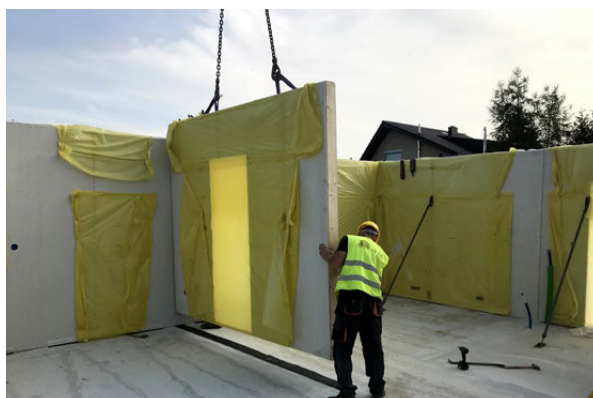
Dostarczenie prefabrykowanych ścian zewnętrznych STEICO na plac budowy (ściany zabezpieczone tymczasowo przed warunkami atmosferycznymi przy użyciu folii PE); posadowienie i zakotwienie ścian do płyty fundamentowej.
