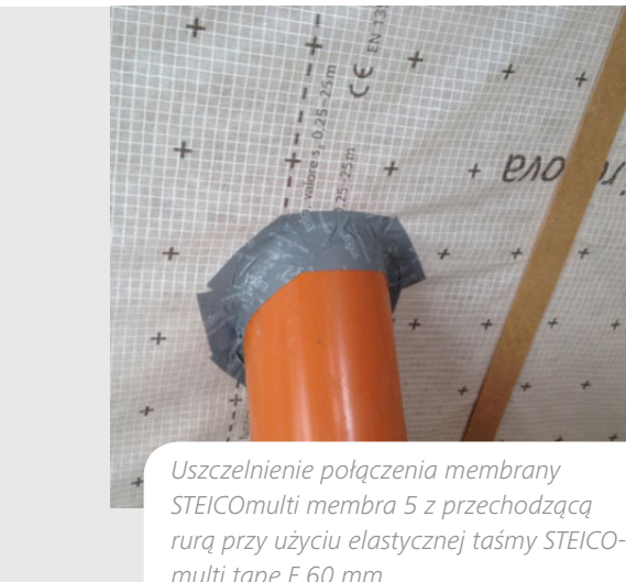
Uszczelnienie połączenia membrany STEICOMulti membra 5 z przechodzącą instalacją elektryczną przy użyciu elastycznej taśmy STEICOMulti tape F 60 mm.
