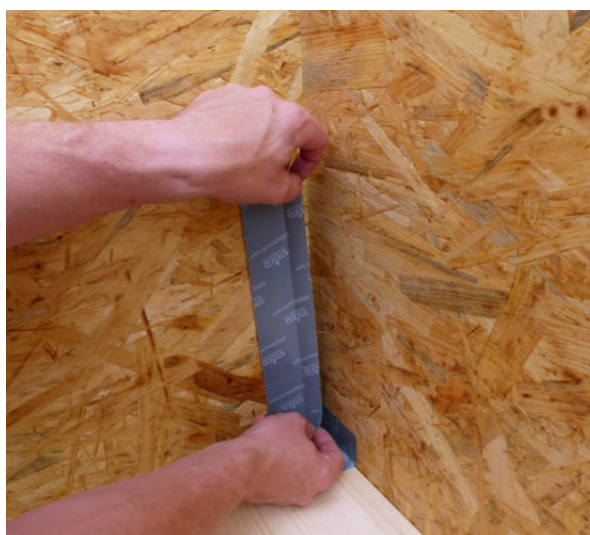
Uszczelnianie spoin między płytami OSB w narożniku przy użyciu taśmy STEICOMulti tape F 60 mm z papierem rozdzielczym.
