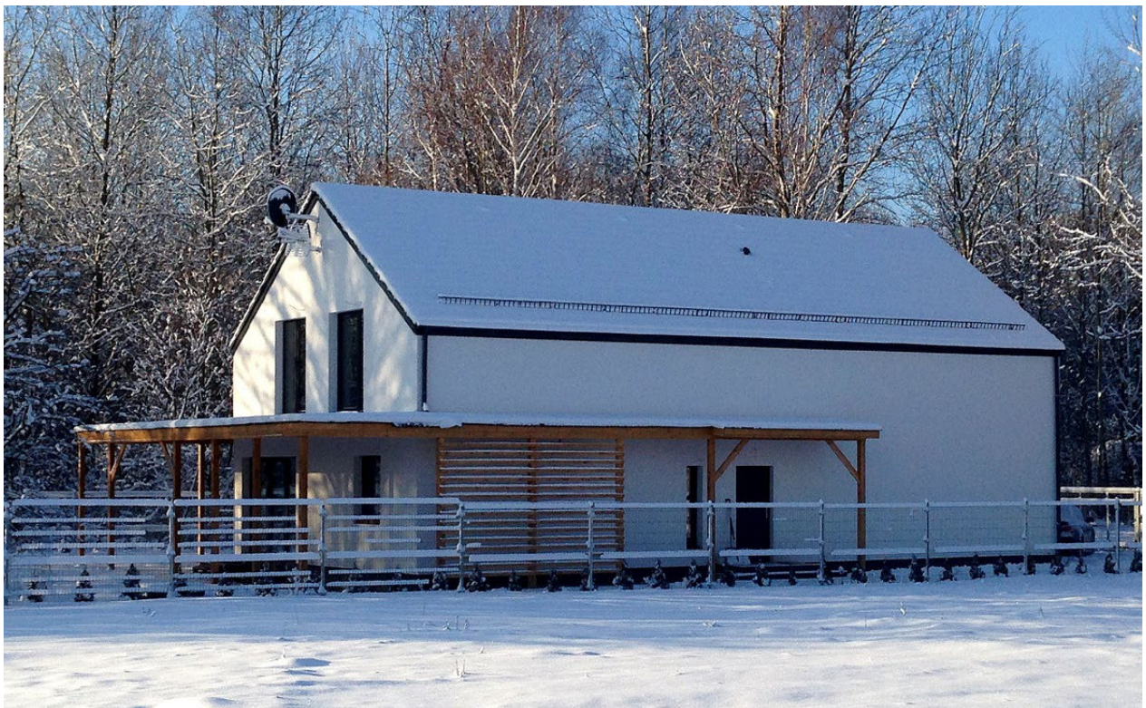
Zdjęcie budynku po zakończeniu prac wykonawczych.
