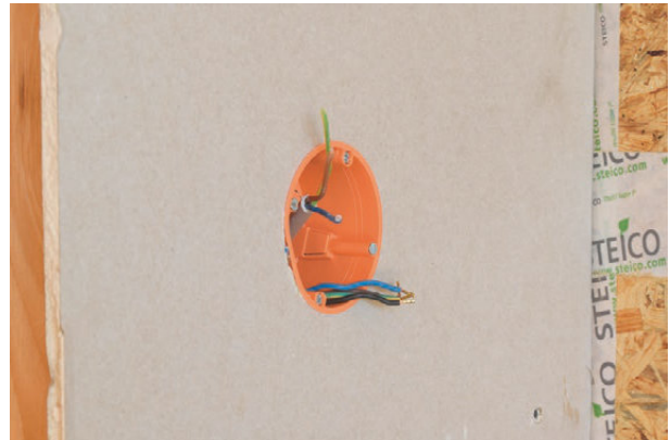
Wycięcie otworu \varnothing 68 mm w płycie wykończeniowej. Przeciągniecie przewodów z otworu, montaż puszki instalacyjnej.
