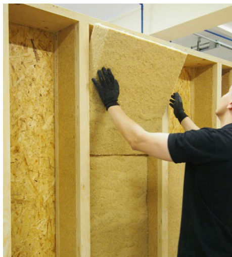
Kontynuacja termoizolacji ściany przy użyciu dociętych fragmentów mat STEICOflex 038.
