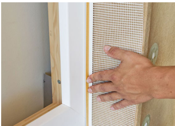
Montaż profilu przyokiennego z siatką na płycie ościeżowej STEICO.
