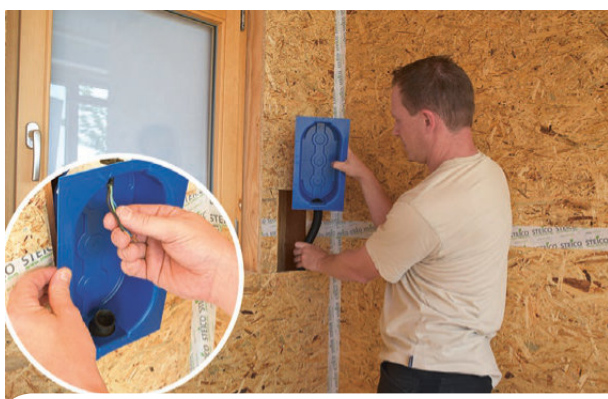
Wprowadzenie końcówki peszla (ewentualnych dalszych instalacji) w fabryczne otwory w kołnierzu STEICO multi box . Kołnierz posiada dwa otwory: 15-22 mm oraz 25-32 mm.
