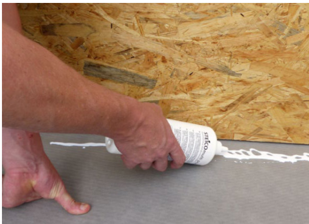
Uszczelnienie połączenia płyta OSB/posadzka – aplikacja gruntu STEICOmulti primer w celu zwiększenia przyczepności podłoża.
