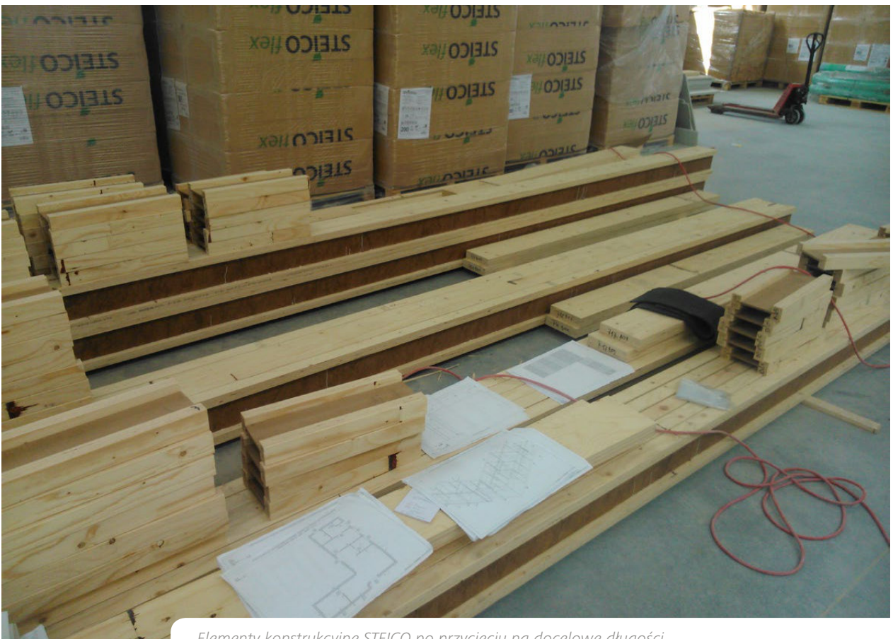
Elementy konstrukcyjne STEICO po przycięciu na docelowe długości.
