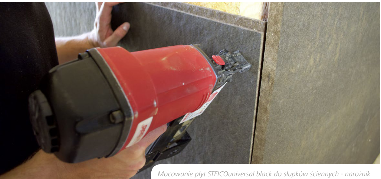
Mocowanie profilowanych płyt STEICOuniversal black do słupków ściennych.
