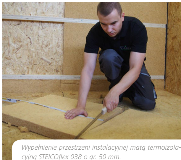
Wypełnienie przestrzeni instalacyjnej matą termoizolacyjną STEICOflex 038 o gr. 50 mm.
