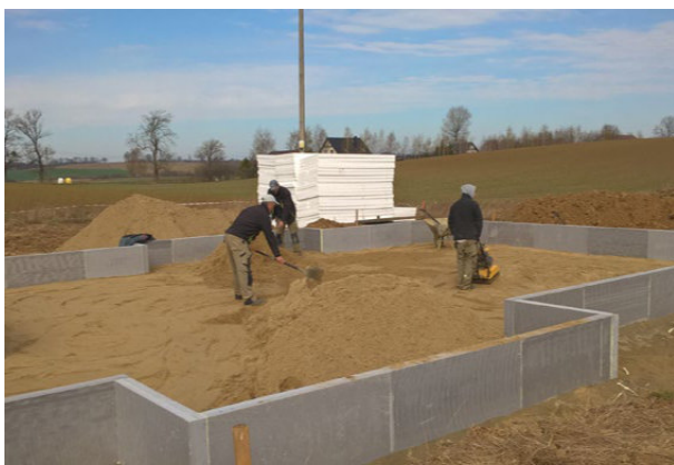
Prace ziemne; przygotowanie płyty fundamentowej.
