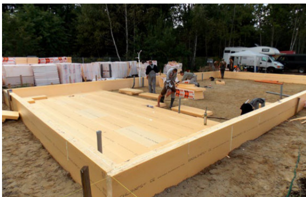
Prace ziemne; przygotowanie płyty fundamentowej.
