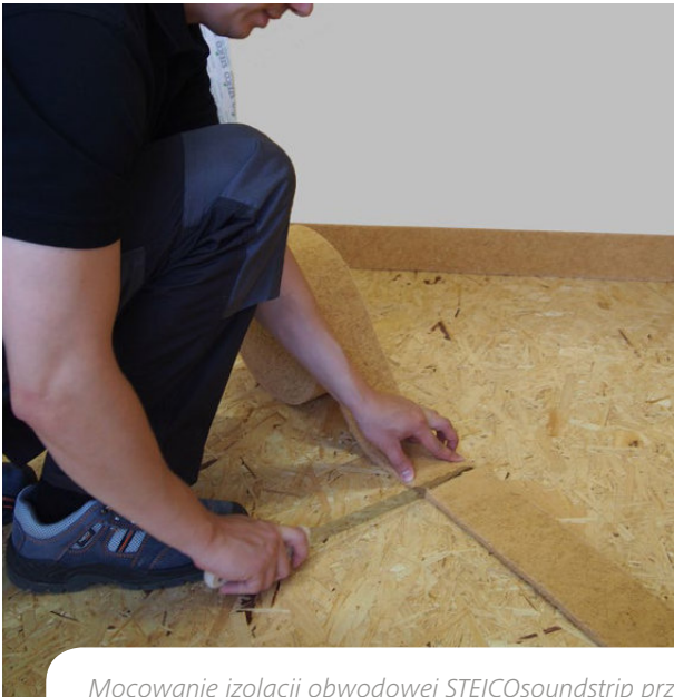
Mocowanie izolacji obwodowej STEICOsoundstrip przy pomocy kleju STEICOmulti connect.
