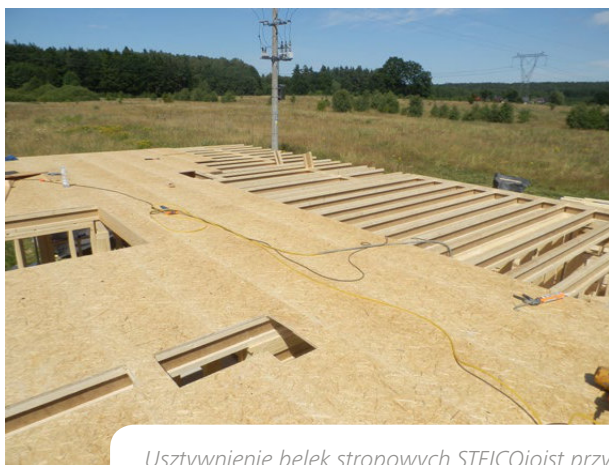
Usztywnienie belek stropowych STEICOjoist przy użyciu płyt OSB/3 25 mm.
