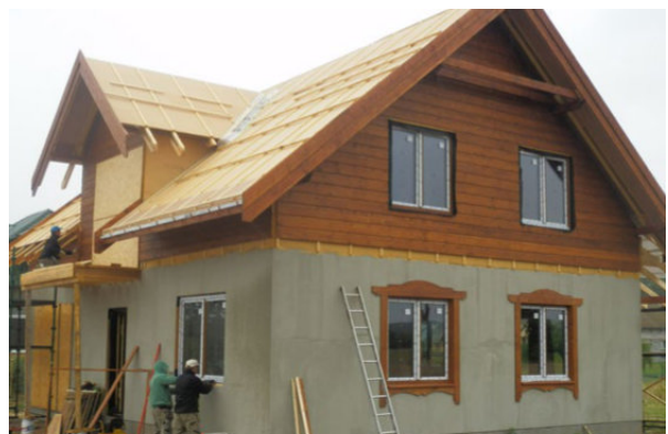
Prace wykończeniowe na dachu: mocowanie płyt nakrokwiowych STEICOuniversal 24 mm do krokwi STEICOjoist 60×240 mm; rozpoczęcie wykańczania fasady: pokrycie płyt STEICOprotect M dry 60 mm systemem tynkarskim.
