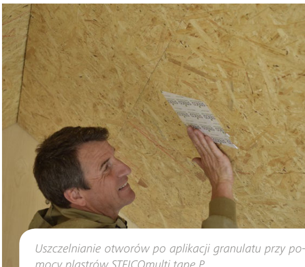
Uszczelnianie otworów po aplikacji granulatu przy pomocy plastrów STEICOmulti tape P.
