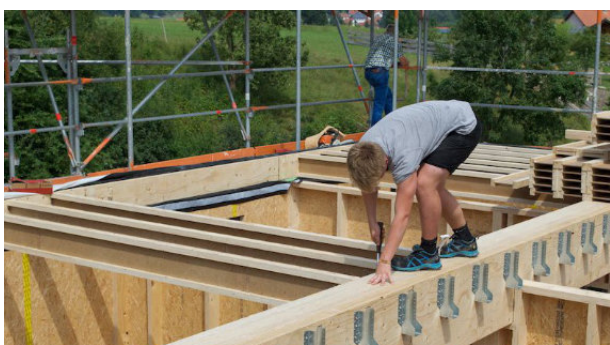
Mocowanie drugorzędnych belek STEICOjoist do wieszaków zamontowanych doczołowo na belce głównej ze STEICO LVL R/ GLVL R.
