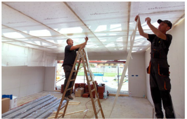
Prace wykończeniowe konstrukcji dachu: membrana dachowa STEICOMulti UDB zainstalowana; montaż membrany parolizacyjnej STEICOMulti renova.
