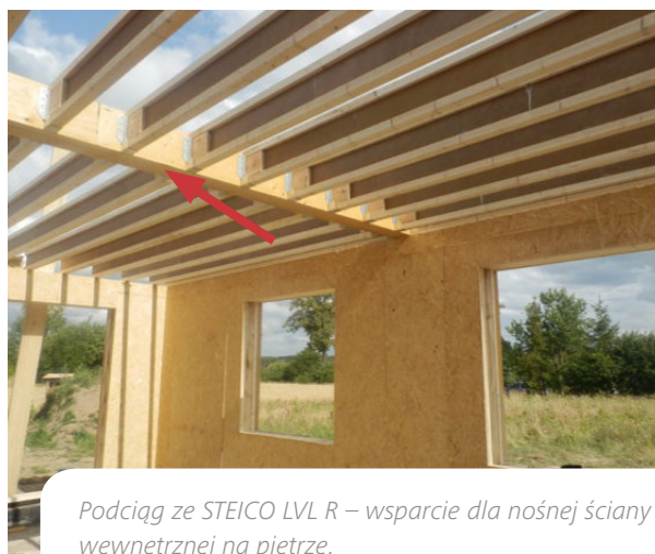
Zagęszczenie belek stropowych STEICOjoist w obszarze posadowienia ściany na piętrze.
