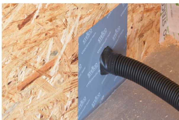
Uszczelnienie przejścia instalacji przy użyciu fragmentu taśmy STEICO multi tape F oraz samoklejącej manszety. Alternatywnie manszetę można zastąpić taśmą klejącą.
