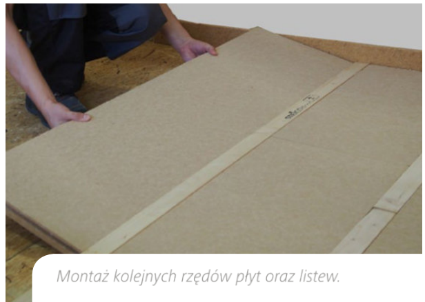
Szczelina dylatacyjna 1-5 mm między listwami montażowymi.
