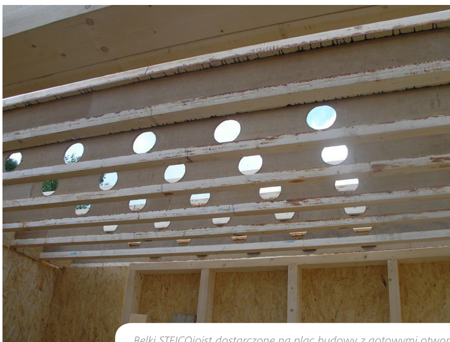
Belki STEICOjoist dostarczone na plac budowy z gotowymi otworami w środkach.
