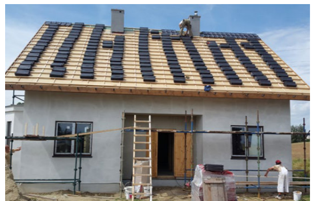
Konstrukcja dachu pokryta płytami nakręciowymi STEICOuniversal 24 mm; rozpoczęcie montażu pokrycia dachowego w postaci dachówki ceramicznej.
