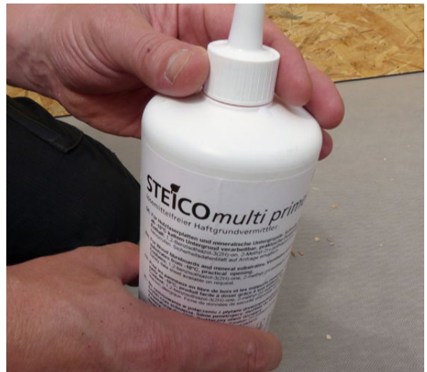
Uszczelnienie połączenia płyta OSB/posadzka – aplikacja gruntu STEICOmulti primer w celu zwiększenia przyczepności podłoża.
