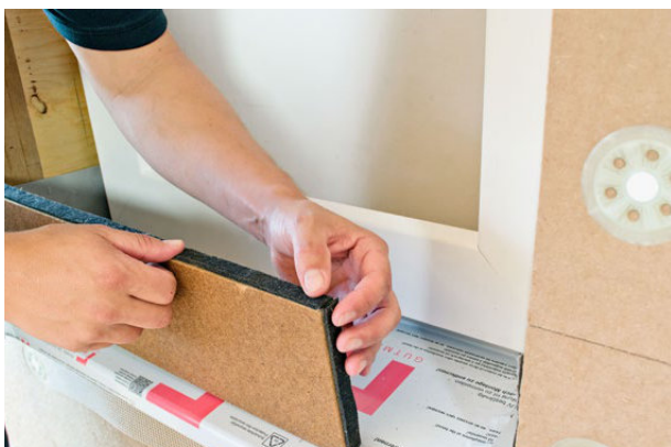
Taśma (uszczelka) rozprężna przymocowana do krawędzi płyty ościeżowej STEICO.
