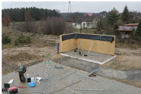
Dostarczenie prefabrykowanych ścian zewnętrznych STEICO na plac budowy (ściany zabezpieczone tymczasowo przed warunkami atmosferycznymi przy użyciu folii budowlanej); posadowienie i zakotwienie ścian do płyty fundamentowej.
