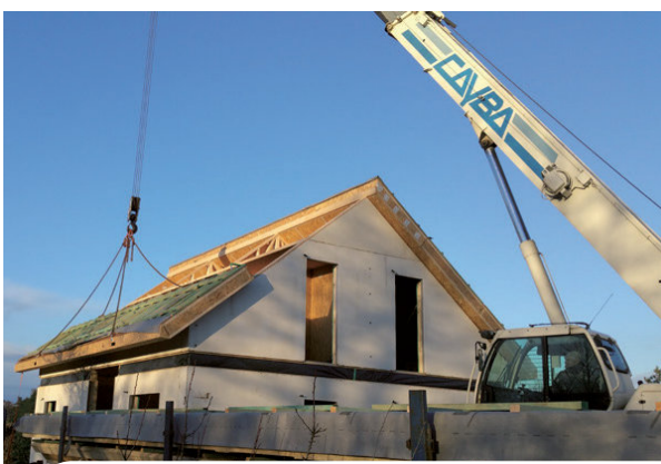
Dalszy montaż konstrukcji dachu.
