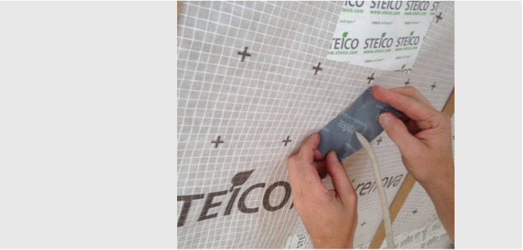
Uszczelnienie połączenia membrany STEICOMulti membra 5 z przechodzącą instalacją elektryczną przy użyciu elastycznej taśmy STEICOMulti tape F 60 mm.
