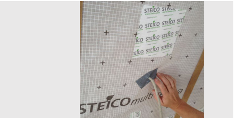
Uszczelnienie połączenia membrany STEICOMulti membra 5 z przechodzącą instalacją elektryczną przy użyciu elastycznej taśmy STEICOMulti tape F 60 mm.
