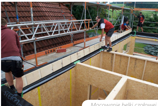
Mocowanie belki czołowej STEICO LVL X do oczepu.
