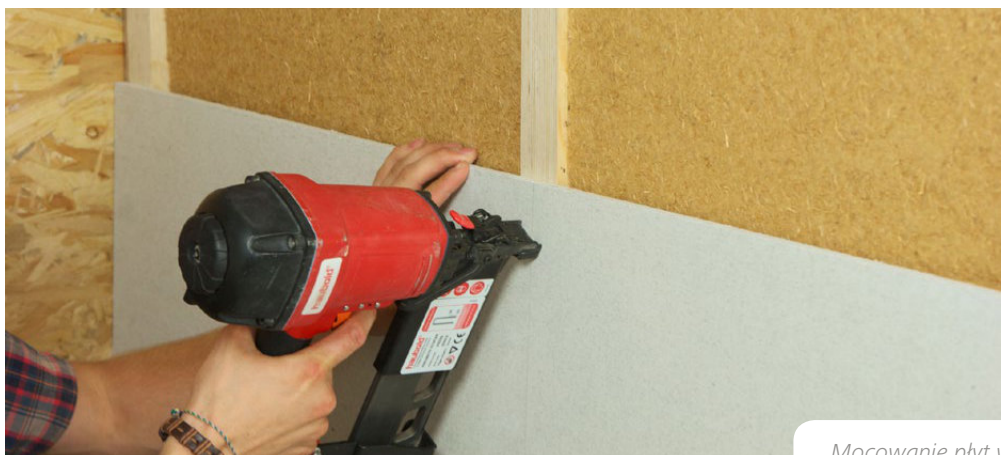
Mocowanie płyt wykończeniowych.
