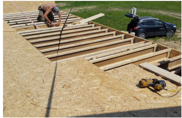
Montaż konstrukcji stropu z belek STEICOjoist oraz ze STEICO LVL R; rozpoczęcie posadowienia prefabrykowanych ścian poddasza na stropie.
