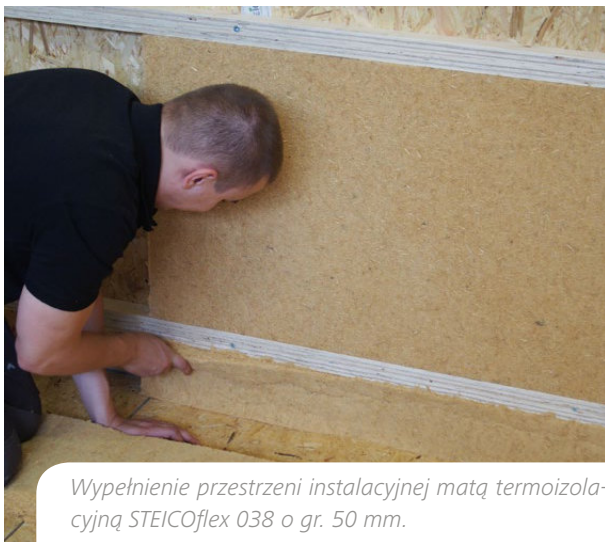
Wypełnienie przestrzeni instalacyjnej matą termoizolacyjną STEICOflex 038 o gr. 50 mm.
