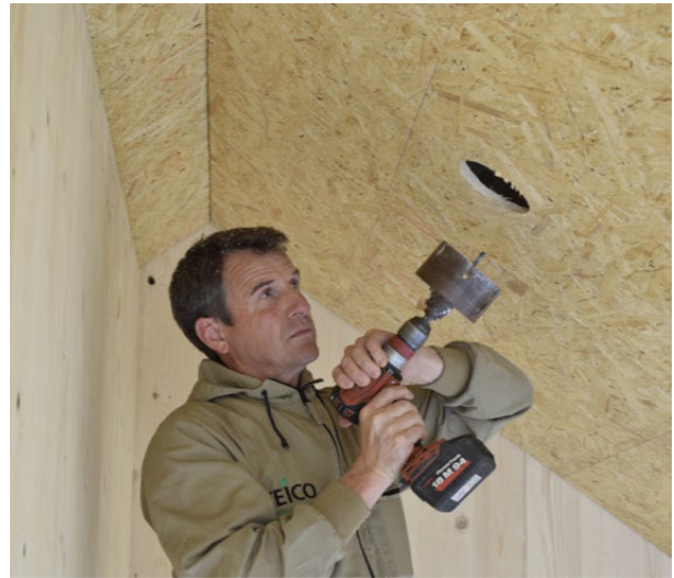
Wykonywanie otworów w płycie konstrukcyjnej OSB/3 przy użyciu otwornicy do drewna.
