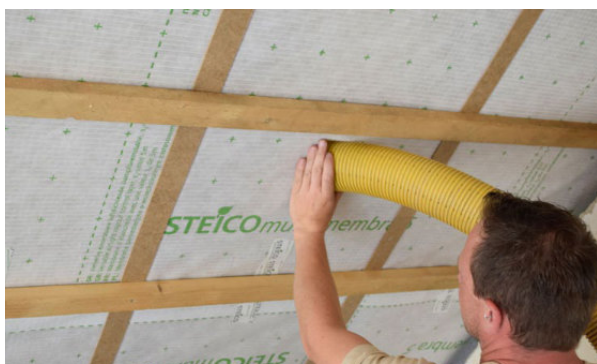
Aplikacja granulatów STEICO poprzez otwory w membranie paroizolacyjnej STEICOmulti membra 5.
