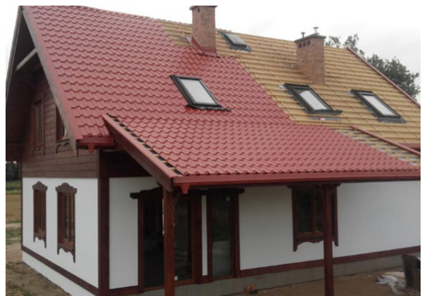
Prace wykończeniowe na dachu: mocowanie płyt nakrokwiowych STEICOuniversal 24 mm do krokwi STEICOjoist 60×240 mm; rozpoczęcie wykańczania fasady: pokrycie płyt STEICOprotect M dry 60 mm systemem tynkarskim.
