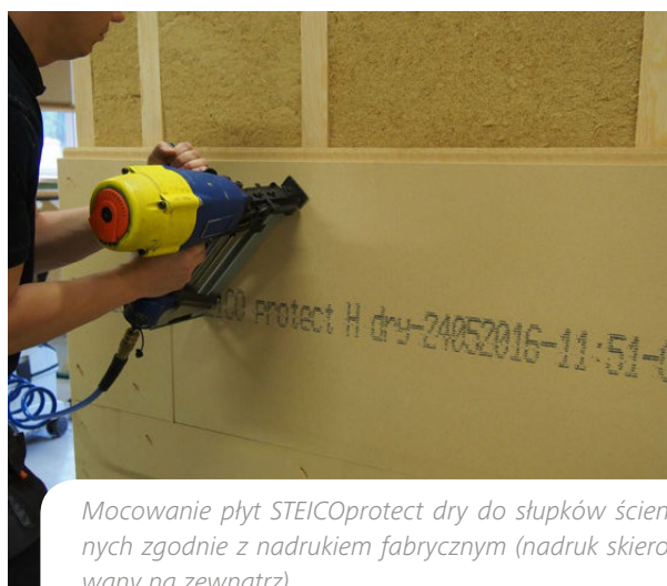
Mocowanie płyt STEICOprotect do słupków ściennych zgodnie z nadrukiem fabrycznym (nadruk skierowany do wewnątrz).
