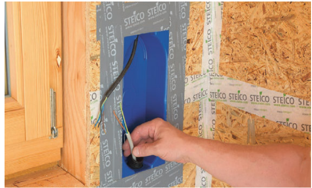
Wprowadzenie właściwych instalacji w światło peszla. W zależności od grubości peszla dopuszcza się wprowadzenie do pięciu przewodów jednocześnie
