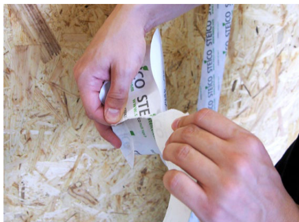
STEICOmultipape P 60 mm – papierowy nośnik umożliwia łatwe dzielenie taśmy na dowolne odcinki przy użyciu rąk, bez konieczności stosowania narzędzi.
