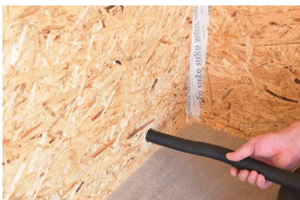
Wprowadzenie peszla w okrągły otwór. Peszel należy przesuwać w kierunku prostokątnego otworu na kołnierz
