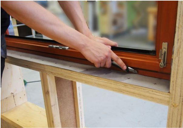
Usunięcie fragmentu membrany STEICO multi UDB po wewnętrznej stronie wbudowanego okna przy pomocy noża introligatorskiego.
