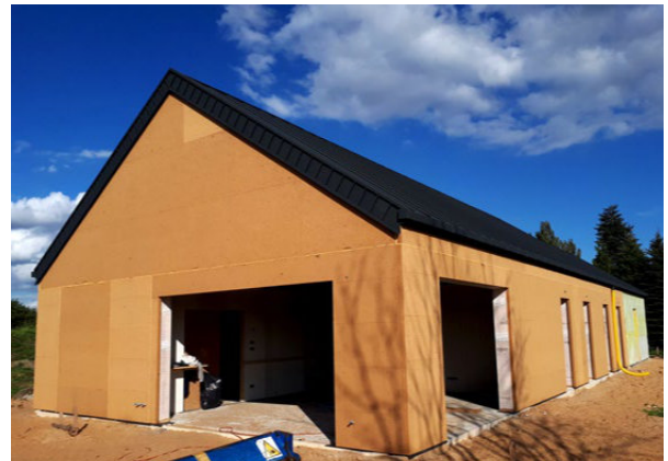
Montaż więźarów kratowych z drewna. Prace wykończeniowe konstrukcji dachu: zainstalowana membrana dachowa STEICOmulti UDB; montaż membrany paroizolacyjnej STEICOmulti renova.
