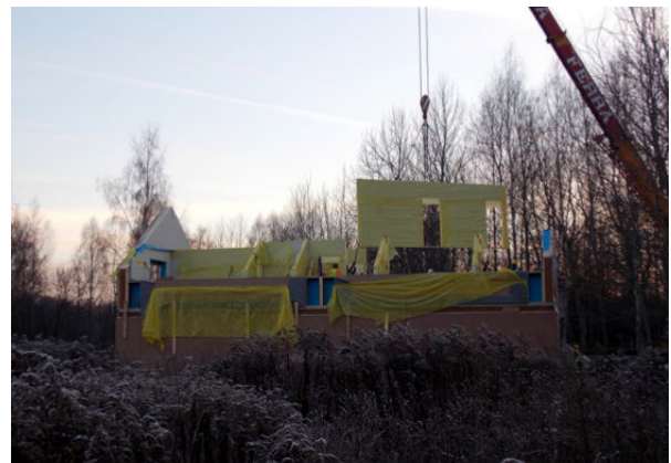
Montaż konstrukcji stropu; rozpoczęcie osadzania prefabrykowanych ścian poddasza.
