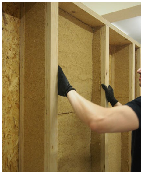
Kontynuacja termoizolacji ściany przy użyciu dociętych fragmentów mat STEICOflex 038.
