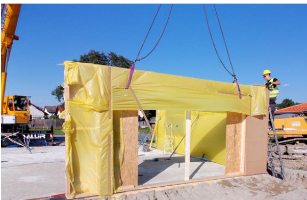
Dostarczenie prefabrykowanych ścian zewnętrznych STEICO na plac budowy (ściany zabezpieczone tymczasowo przed warunkami atmosferycznymi przy użyciu folii PE); posadzenie i zakotwienie ścian do płyty fundamentowej.
