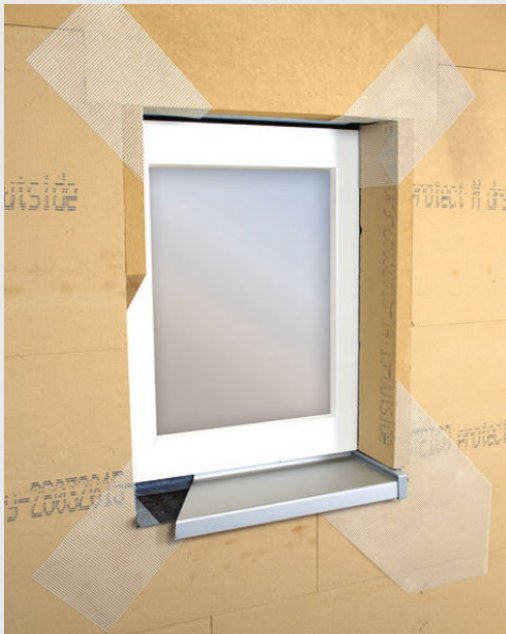
Zbrojenie narożników otworów okiennych przy użyciu siatki diagonalnej z włókna szklanego
