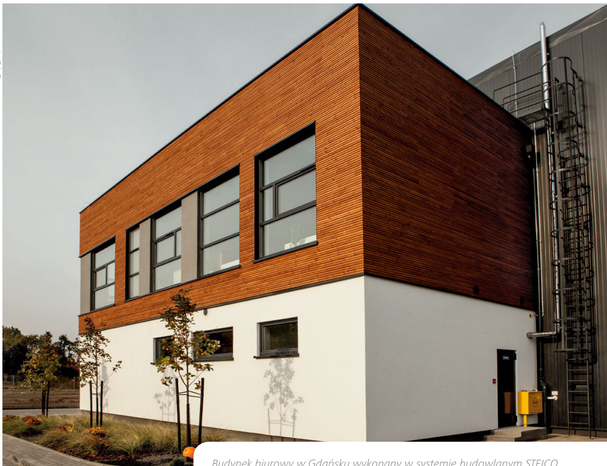
Budynek biurowy w Gdańsku wykonany w systemie budowlanym STEICO.
