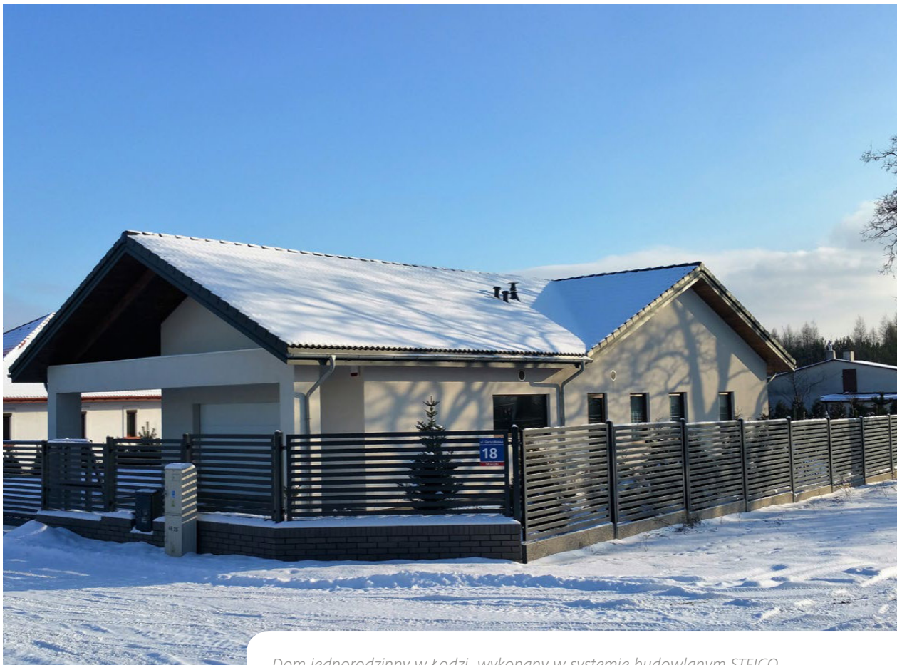
Dom jednorodzinny w Łodzi, wykonany w systemie budowlanym STEICO.
