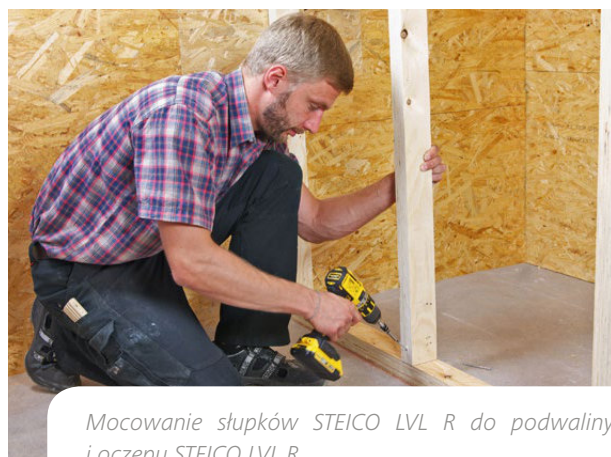
Montaż podwaliny i oczepty STEICO LVL R na zainstalowanej wcześniej izolacji akustycznej w formie pasków STEICO soundstrip .
