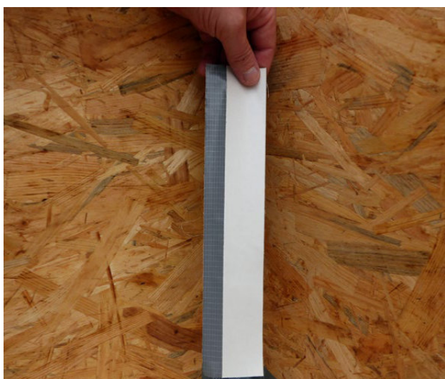
Uszczelnianie spoin między płytami OSB w narożniku przy użyciu taśmy STEICOMulti tape F 60 mm z papierem rozdzielczym.
