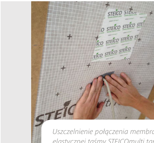
Uszczelnienie połączenia membrany STEICOMulti membra 5 z przechodzącą instalacją elektryczną przy użyciu elastycznej taśmy STEICOMulti tape F 60 mm.
