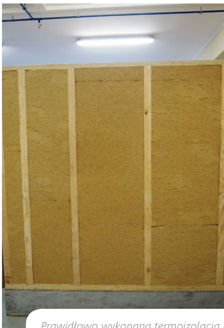
Prawidłowo wykonana termoizolacja przestrzeni między słupkami STEICOWall.
