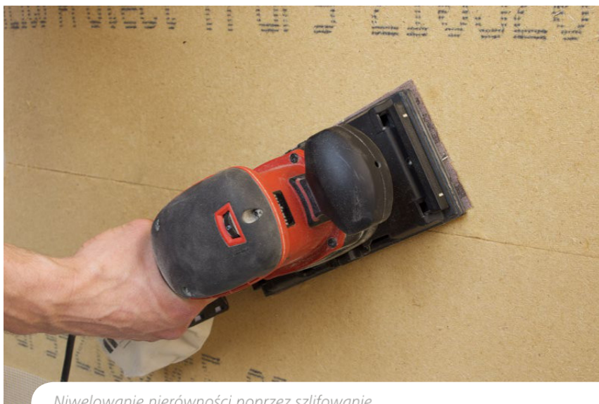
Niwelowanie nierówności poprzez szlifowanie.
