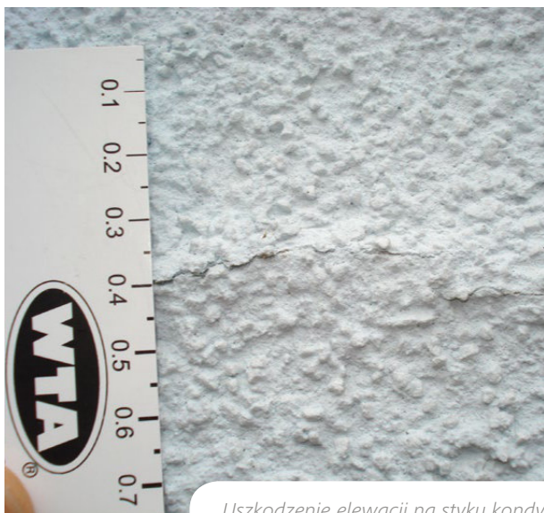
Uszkodzenie elewacji na styku kondygnacji w efekcie skurczu drewna litego o ok. 8 mm.
