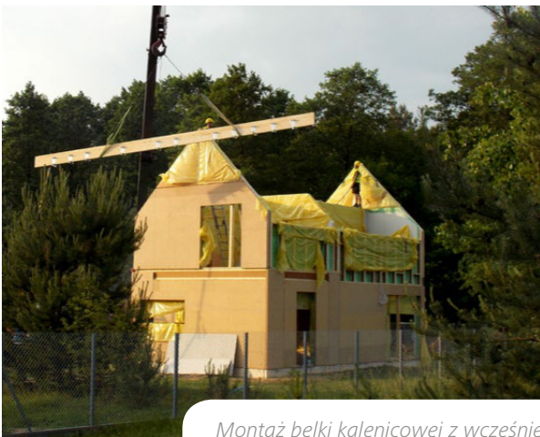
Montaż belki kalenicowej z wcześniej przymocowanymi okuciami ciesielskimi.
