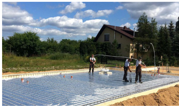
Prace ziemne: przygotowanie płyty fundamentowej. System ogrzewania podłogowego „zatopiony” w płycie fundamentowej.
