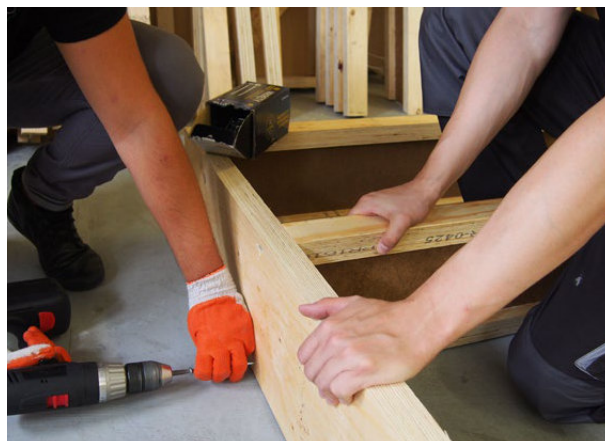
Połączenie belek STEICOWall z podwaliną/oczepem przy pomocy wkrętów ciesielskich.
