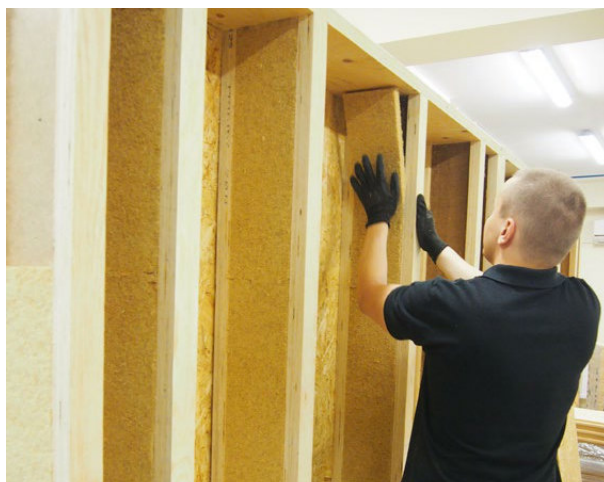
Montaż pasków termoizolacyjnych poprzez wciśnięcie manualne w profil belki dwuteowej.
