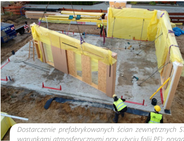
Prefabrykacja ścian STEICO w zakładzie SZREDER A.C.: słupki ścienne z belek dwuteowych STEICOWall 60x240 mm, ociep i podwalina ze STEICO LVL R 45x240 mm; izolacja cieplna STEICOflex 038 240 mm oraz STEICOprotect H 60 mm.
