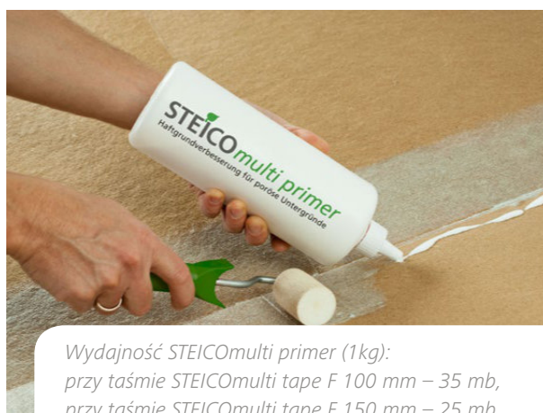
Uszczelnienie styku zagruntowanych płyt przy użyciu taśmy STEICOmulti tape F 150 mm z paskiem rozdzielczym.
