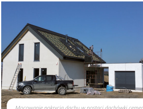
Mocowanie pokrycia dachu w postaci dachówki cementowej.
