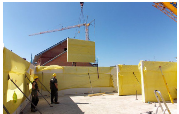
Dostarczenie prefabrykowanych ścian zewnętrznych STEICO na plac budowy (ściany zabezpieczone tymczasowo przed warunkami atmosferycznymi przy użyciu folii PE); posadzenie i zakotwienie ścian do płyty fundamentowej.
