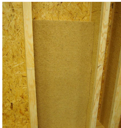
Wypełnienie przestrzeni między słupkami STEICOWall 60/240 mm przy pomocy mat STEICOflex 038 120 mm – układanie mat w dwóch warstwach.
