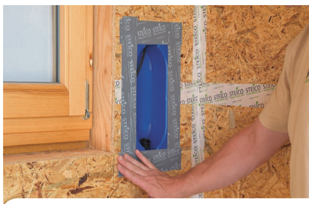
Szczelne połączenie kołnierza z płytą OSB (lub membraną paroizolacyjną) przy pomocy taśmy STEICO multi tape - typ F lub P.
