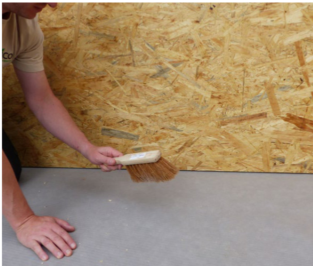
Uszczelnienie połączenia płyta OSB/posadzka – aplikacja gruntu STEICOmulti primer w celu zwiększenia przyczepności podłoża.
