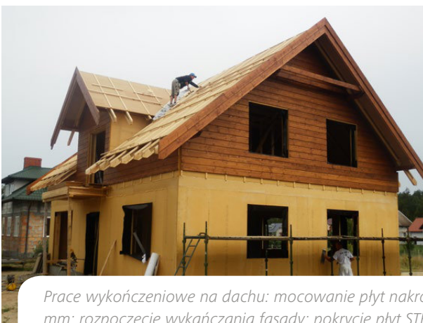
Montaż krokwi dachowych STEICOjoist 60×240 mm
