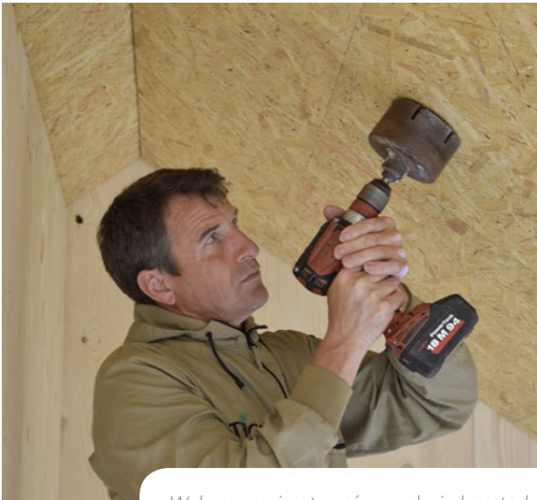
Wykonywanie otworów w płycie konstrukcyjnej OSB/3 przy użyciu otwornicy do drewna.
