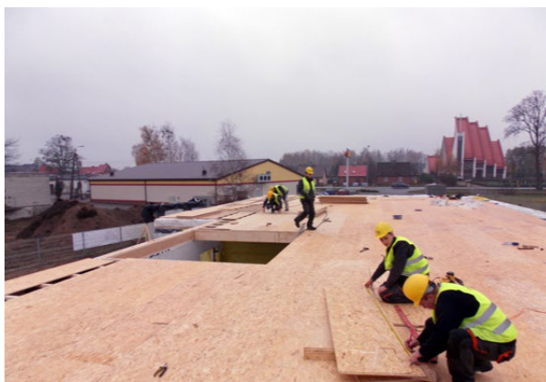
Usztywnienie belek stropowych STEICOjoist przy użyciu płyt OSB/3 25 mm.
