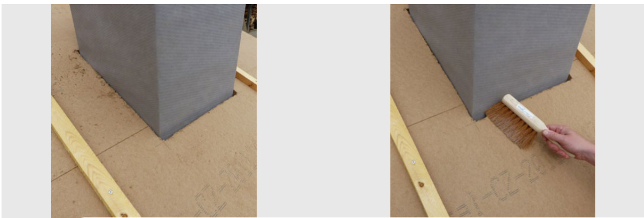
Oczyszczenie powierzchni płyt termoizolacyjnych STEICO z kurzu, pozostałości włókien w obszarze połączenia z kominem systemowym/przewodem wentylacyjnym.
