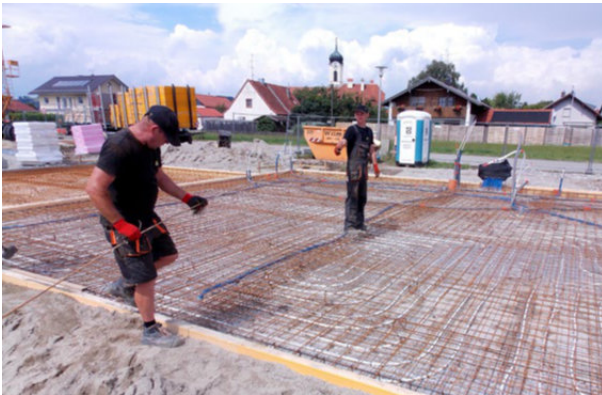
Prace ziemne: przygotowanie płyty fundamentowej. System ogrzewania podłogowego „zatopiony” w płycie fundamentowej.
