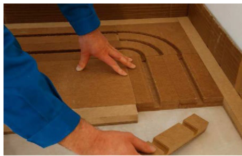
Montaż systemu ogrzewania podłogowego IDEAL ECO. Grubość płyty izolacyjnej STEICO 30 mm. Źródło: JUPITER Heating Systems Limited.
