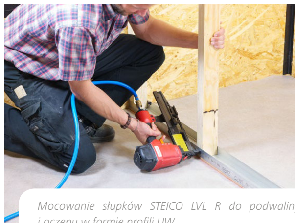
Montaż podwaliny i oczepty w formie profili UW na zainstalowanej wcześniej izolacji akustycznej w formie pasków STEICO soundstrip .
