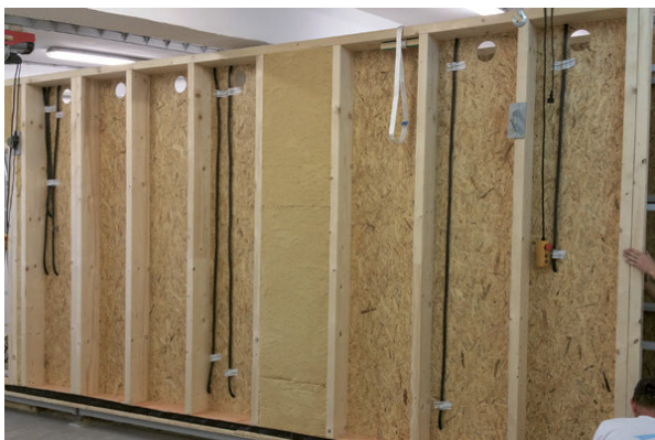
Prefabrykacja ścian STEICO w zakładzie FuturaDom Sp. z o.o.: słupki ścienne z belek KVH/STEICOwall 60×160 mm, oczipce i podwalina ze STEICO LVL R 39/45×160 mm; termoizolacja STEICOzell 160 mm oraz STEICOprotect L dry 100 mm.
