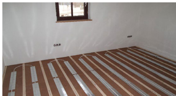
Wykonanie kanałów pod system ogrzewania podłogowego w systemie STEICOfloor przy użyciu wyrzynarki elektrycznej.
