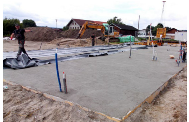
Prace ziemne: przygotowanie płyty fundamentowej. System ogrzewania podłogowego „zatopiony” w płycie fundamentowej.
