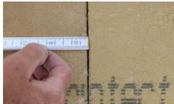
Szczelina między płytami fasadowymi STEICO (szerokość szczeliny w przedziale 2–5 mm).
