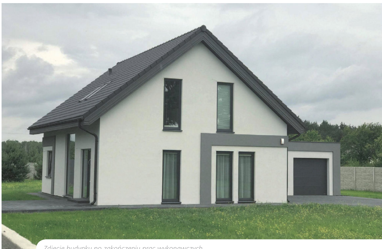
Zdjęcie budynku po zakończeniu prac wykonawczych.
