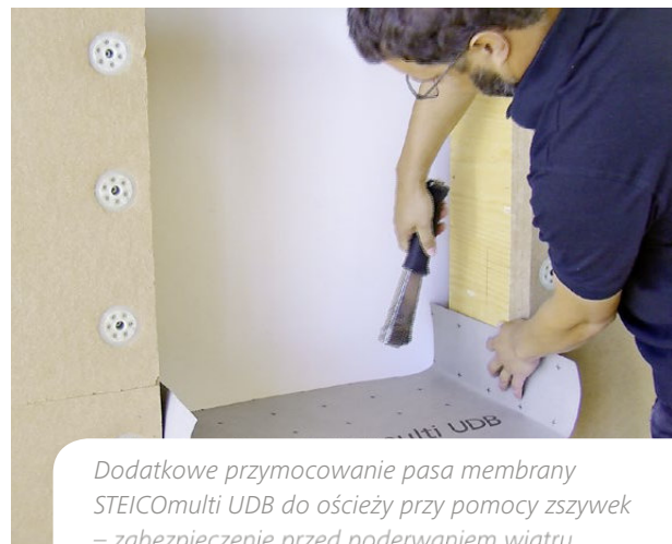
Wałek masy STEICO multi fill ze spadkiem skierowanym na zewnątrz – zabezpieczenie dolnej płaszczyzny otworu okiennego przed wodą spływającą po ościeżach.
