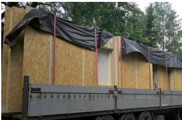
Dostarczenie prefabrykowanych ścian zewnętrznych STEICO na plac budowy (ściany zabezpieczone tymczasowo przed warunkami atmosferycznymi przy użyciu folii budowlanej); posadowienie i zakotwienie ścian do płyty fundamentowej.
