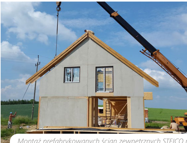
Montaż prefabrykowanych ścian zewnętrznych STEICO na stropie – ściany szczytowe i kalenicowe.
