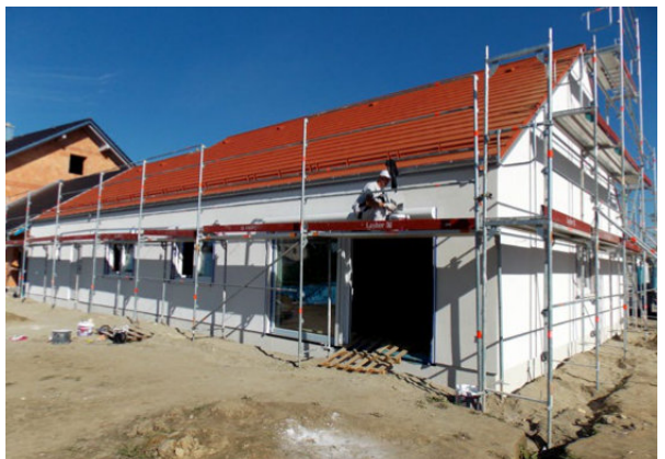
Prace wykończeniowe konstrukcji dachu: membrana dachowa STEICOMulti UDB zainstalowana; montaż membrany parolizacyjnej STEICOMulti renova.
