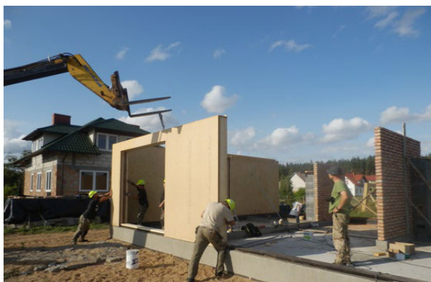
Dostarczenie prefabrykowanych ścian zewnętrznych STEICO na plac budowy; posadzenie i zakotwienie ścian do płyty fundamentowej.
