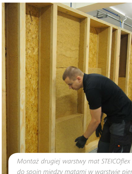
Kontynuacja termoizolacji ściany przy użyciu dociętych fragmentów mat STEICOflex 038.
